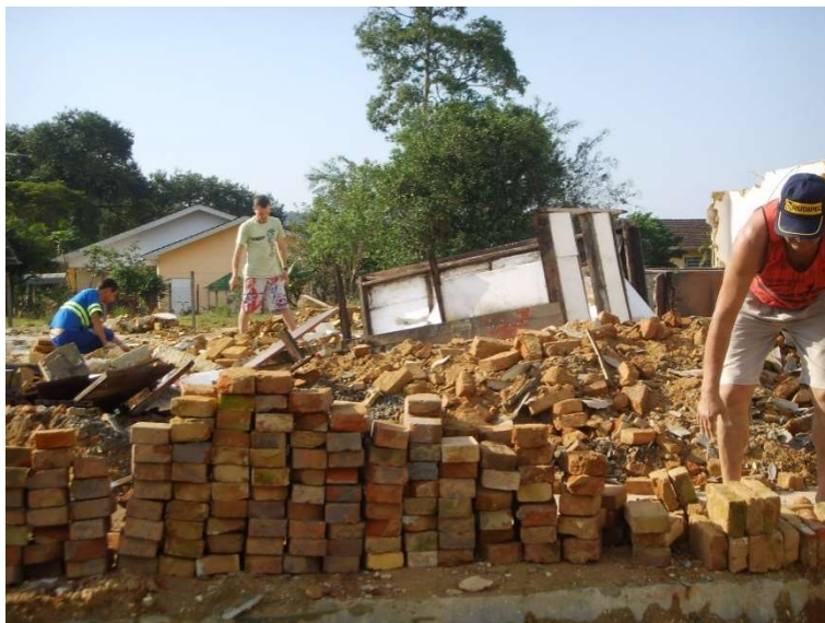
Figura 3: Separação de material para reutilização em construção
