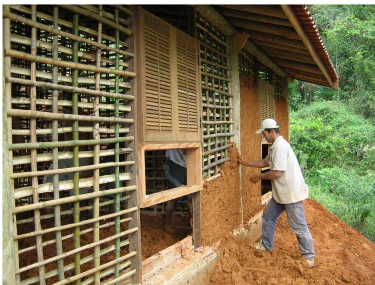
Figura 5: Construção com estrutura em bambu e solo
