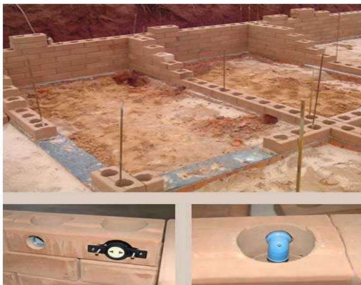
Figura 17: Sistema Construtivo bloco ecológico ou solo-cimento
