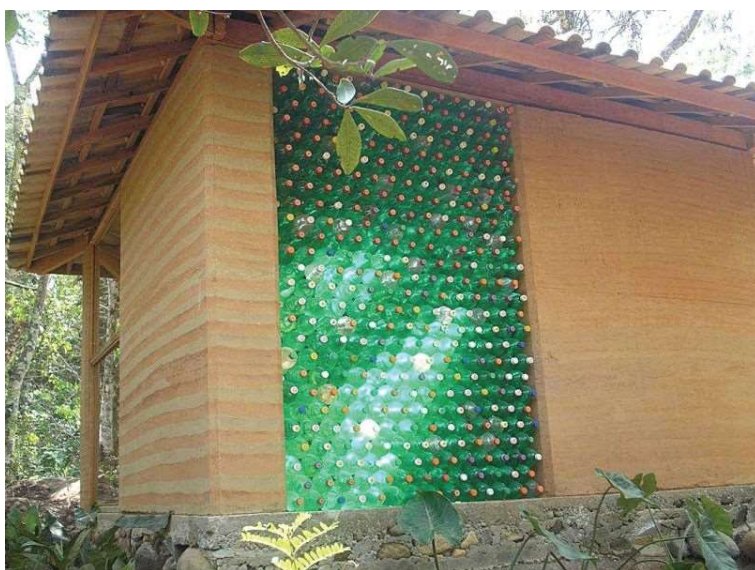
Figura 4: Construção com reutilização de garrafa PET
