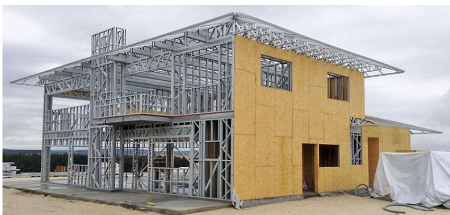
Figura 2: Construção em Steel Frame
