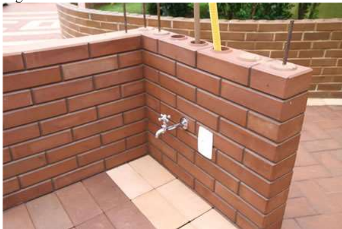
Figura 12 – Condutores elétricos e hidráulicos.
