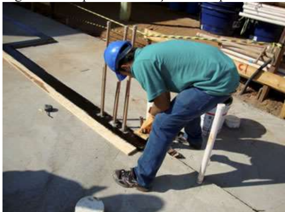
Figura 6 – Impermeabilização contrapiso.
