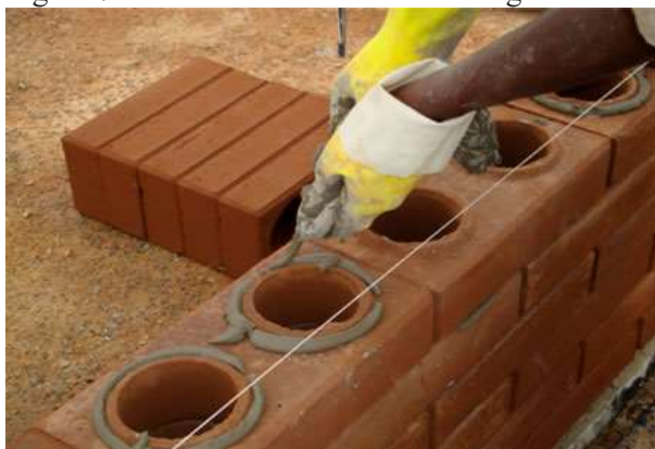
Figura 7 – Cola PVA misturada com argamassa.
