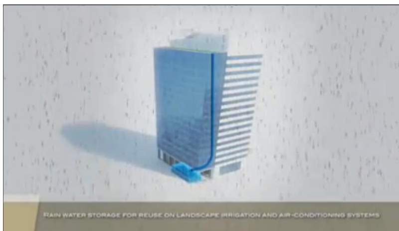
Figura 06 – Captação da água da chuva
