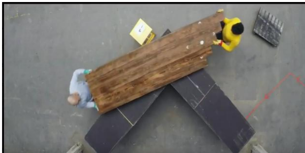
Figura 7 - Construção de ponte
