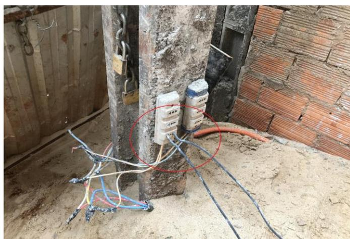
**Figura 19** - Amostra B, condutor conectada diretamente em ponto tomada.
