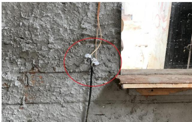
**Figura 12** - Amostra A, isolamento inadequado.
