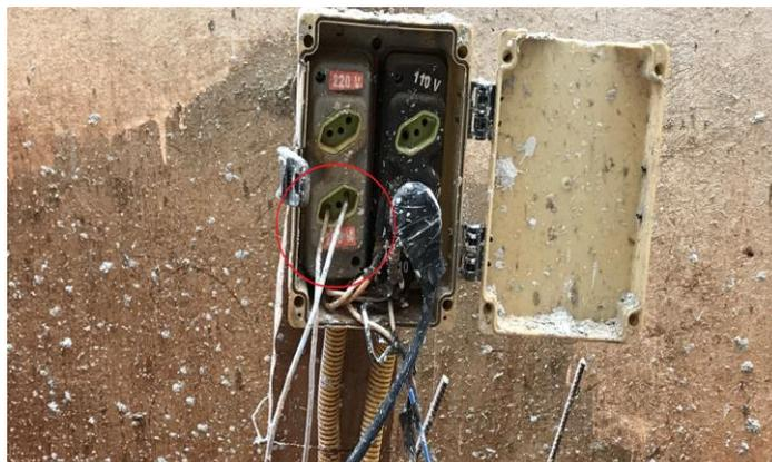
**Figura 18** - Amostra A, condutor conectada diretamente em ponto tomada.
