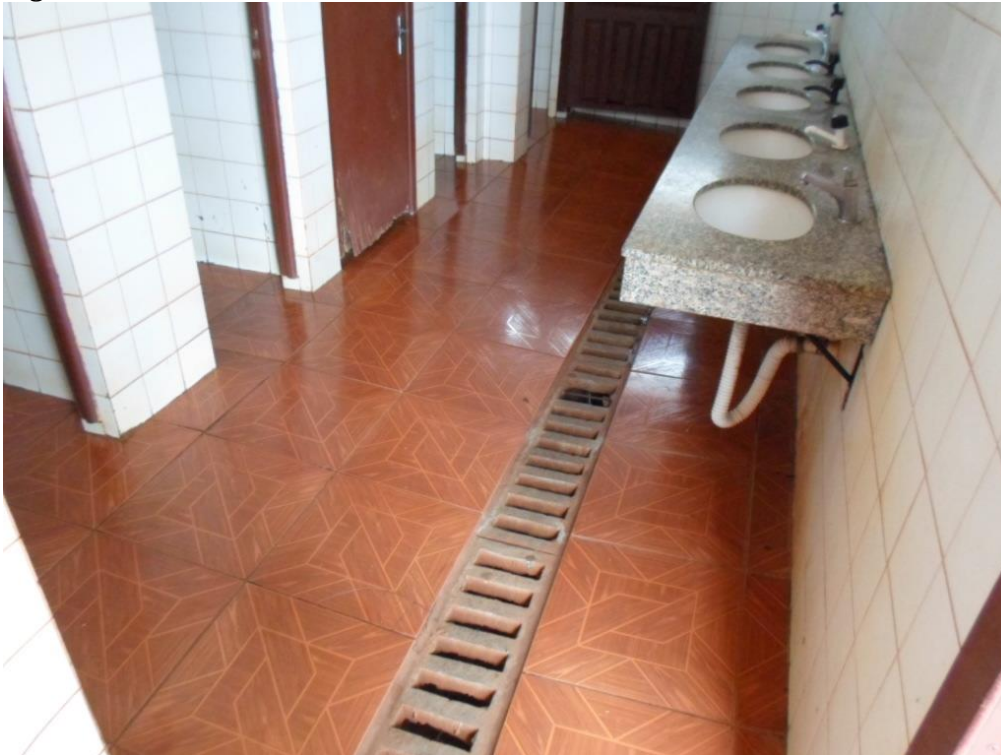
Figura 19: Estrutura interna do banheiro.
