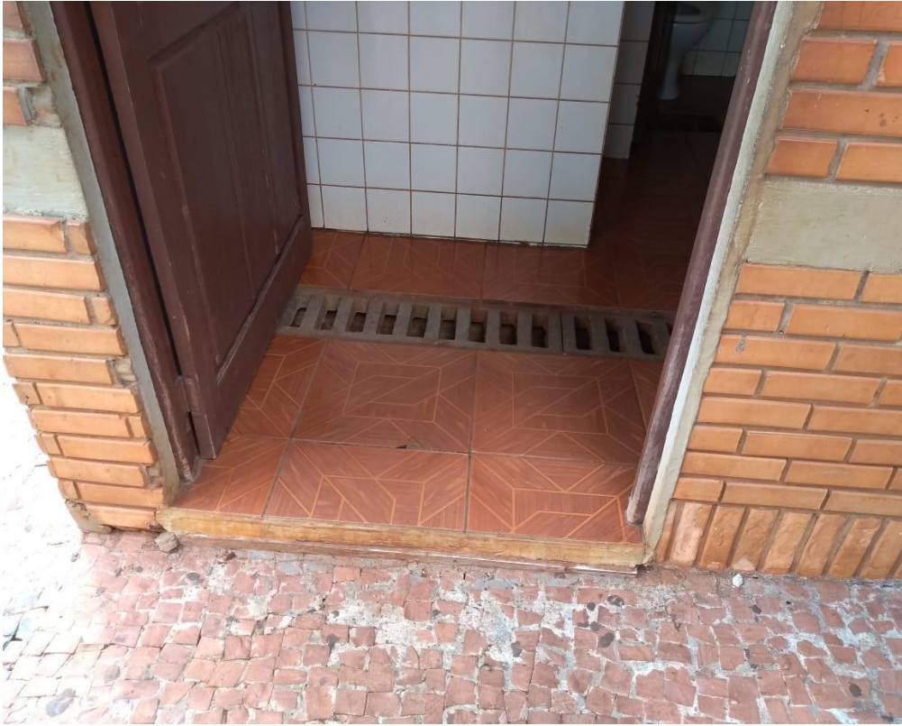
Figura 18: Porta de entrada do banheiro.
