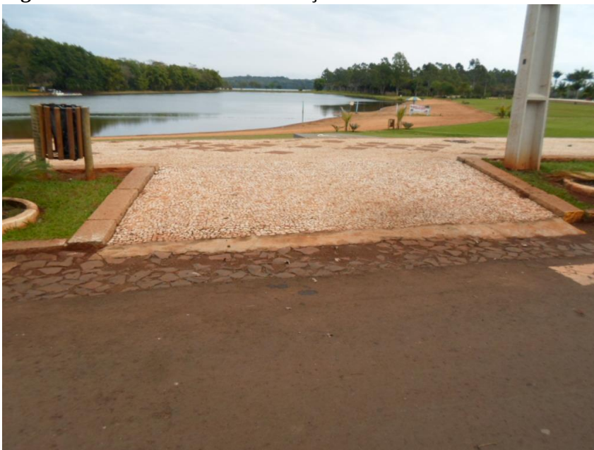
Figura 10: Acesso secundário ao calçadão.
