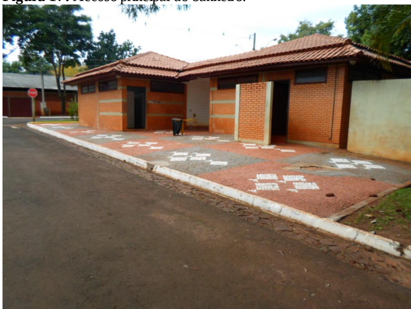
Figura 17: Acesso principal ao banheiro.
