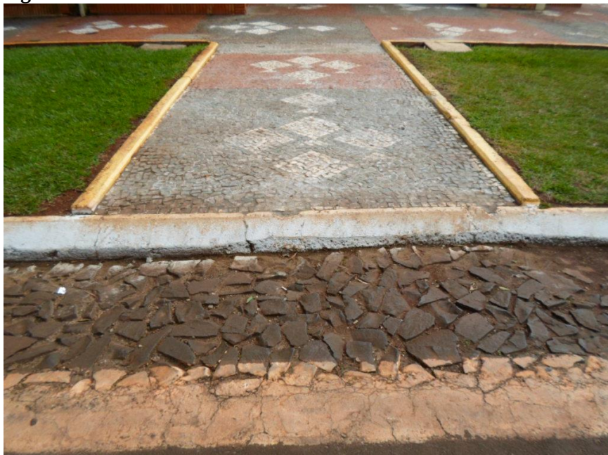
Figura 25: Acesso secundário ao banheiro.
