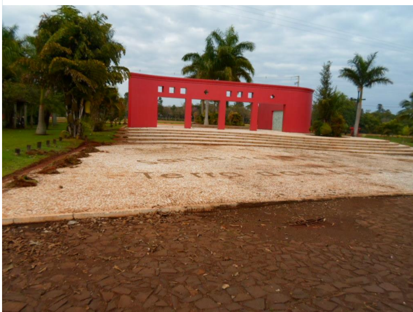
Figura 7: Acesso principal ao calçadão.
