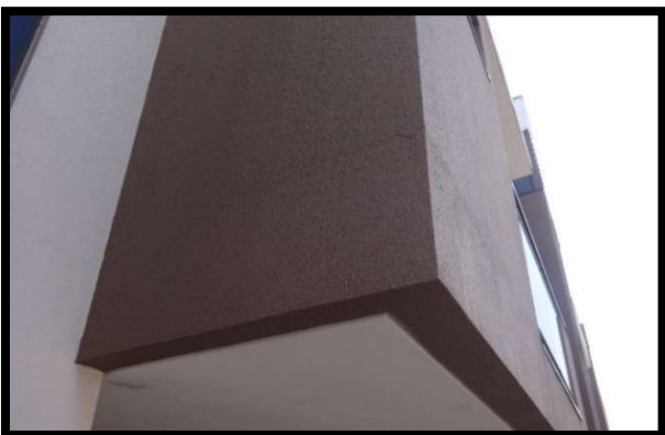
Figura 10 - Fissuração e trincas guarda corpo da sacada da suíte.
