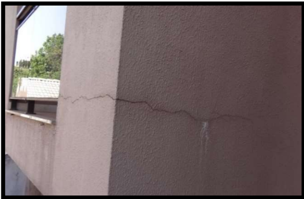
Figura 10 - Fissuração e trincas guarda corpo da sacada da suíte.
