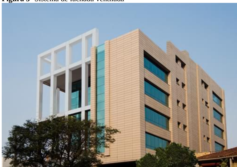
Figura 5- Sistema de fachada ventilada
