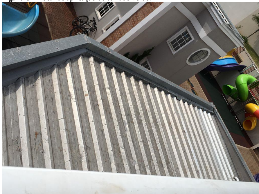
Figura 8 – Local de aplicação do telhado verde.
