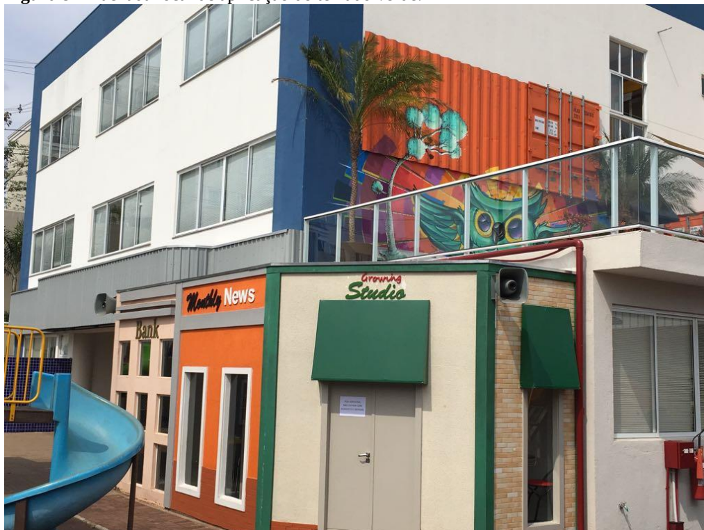
Figura 9 – Fachada local de aplicação do telhado verde.
