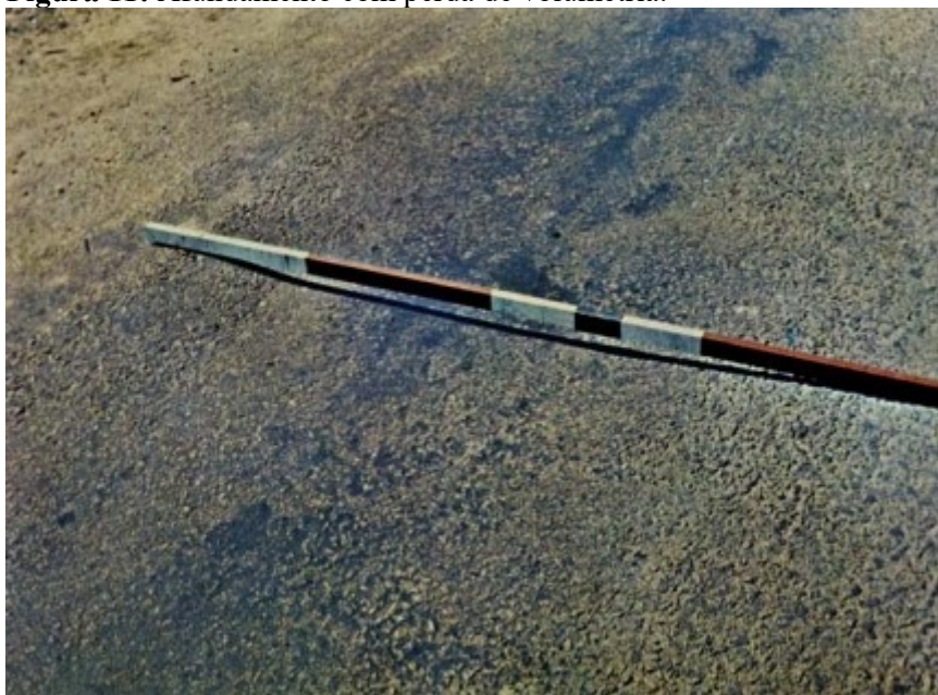
Figura 11: Afundamento com perda de volumetria.
