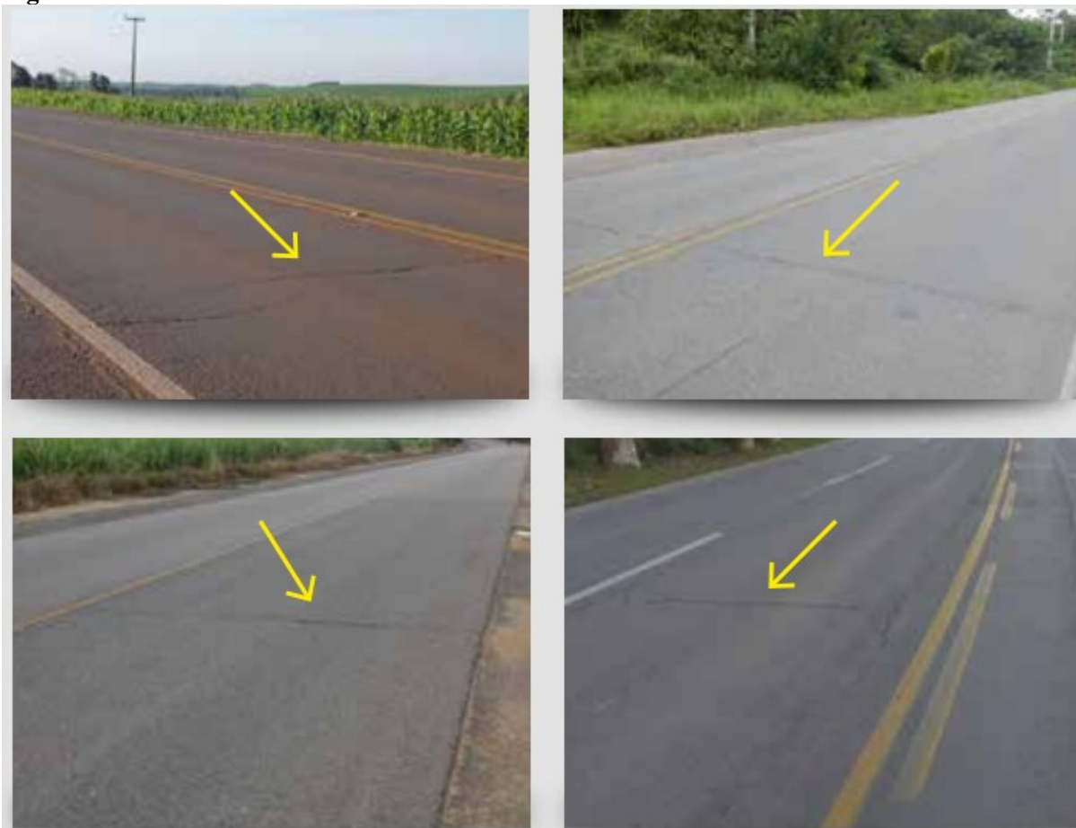
Figura 3: Trincas transversais.
