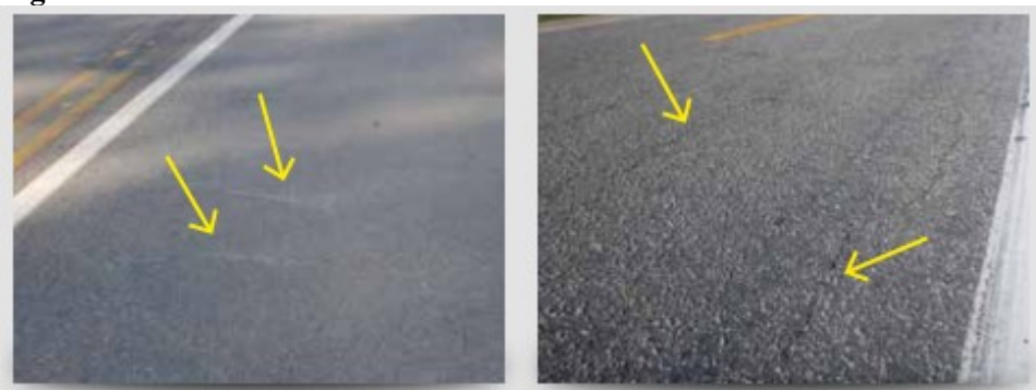
Figura 6: Fissuras.
