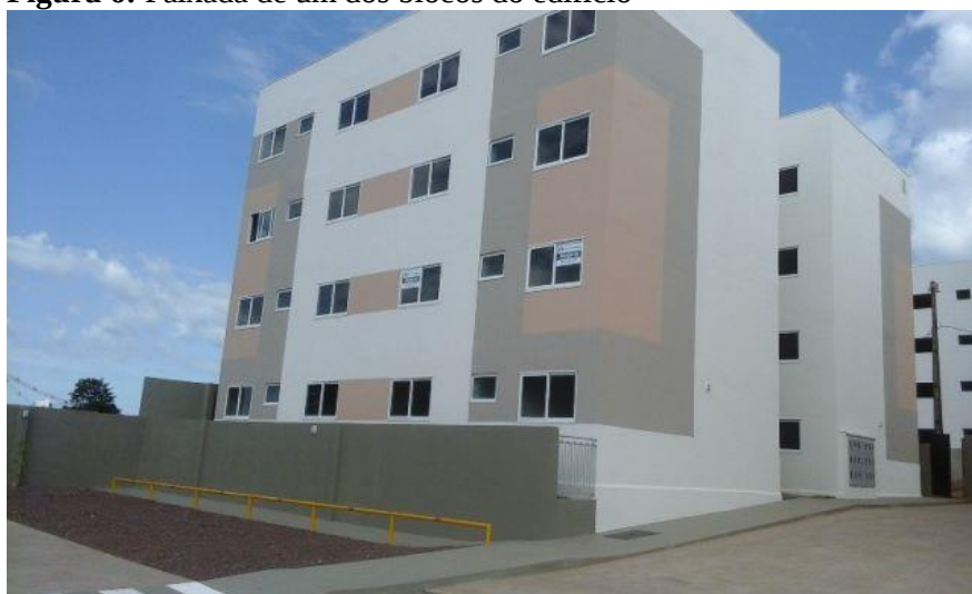
Figura 6: Faixada de um dos blocos do edifício
