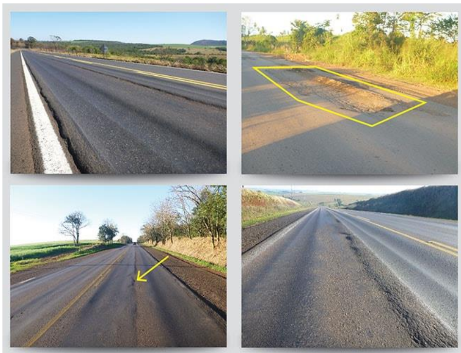
Figura 6 - Afundamento Plástico
