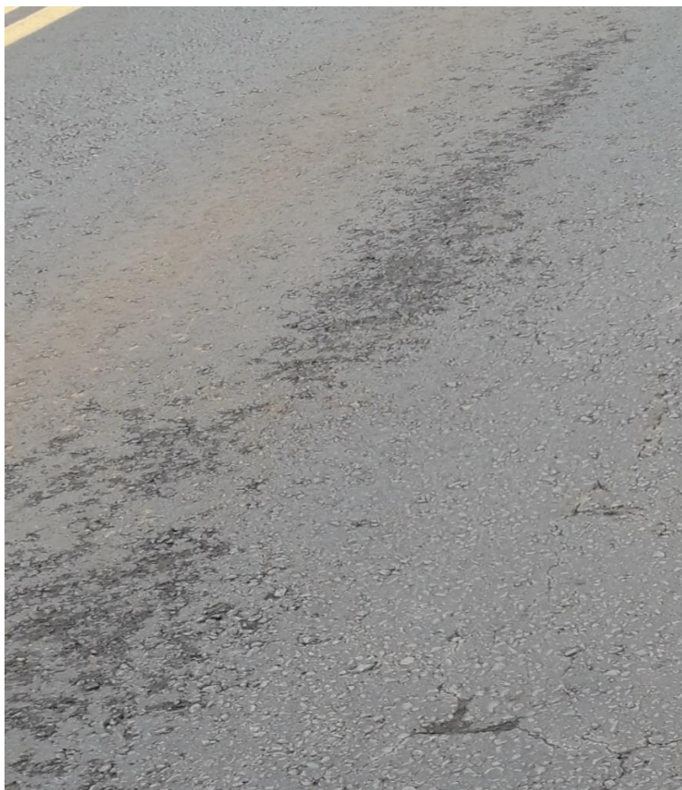
Figura 16 – Desgaste
