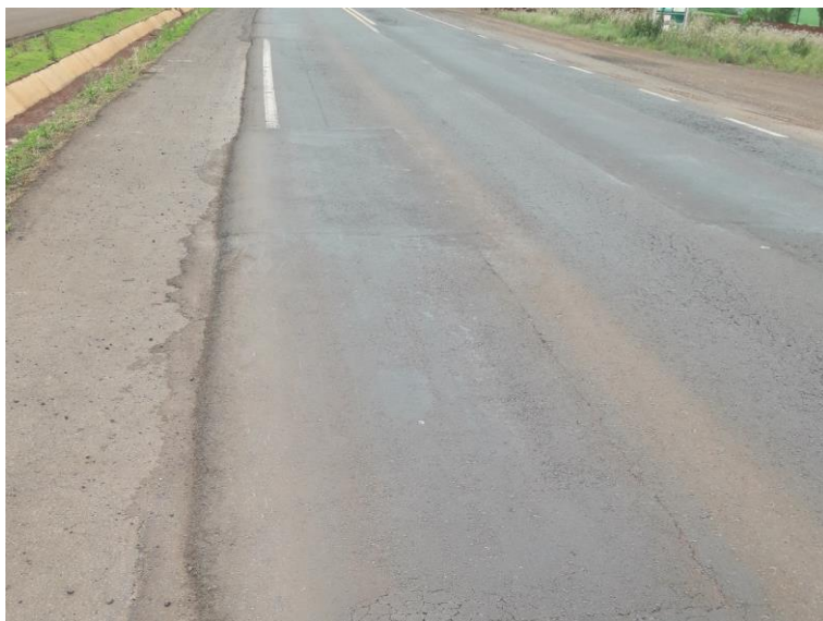
Figura 14 – Remendo com Exsudação
