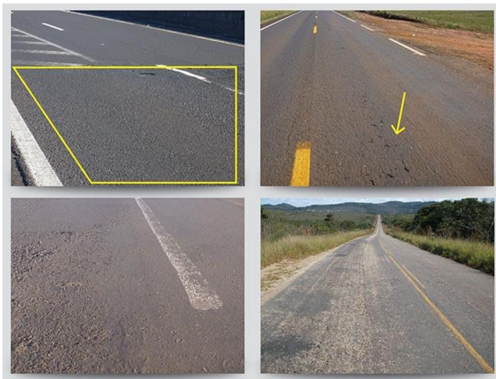
Figura 9 - Desgaste
