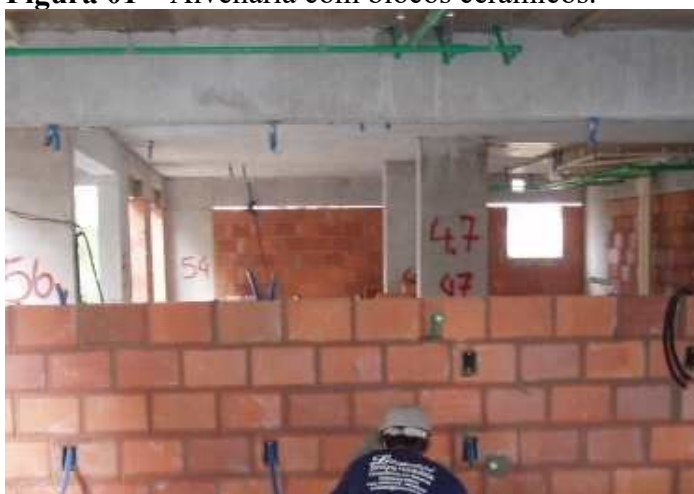
Figura 01 – Alvenaria com blocos cerâmicos.
