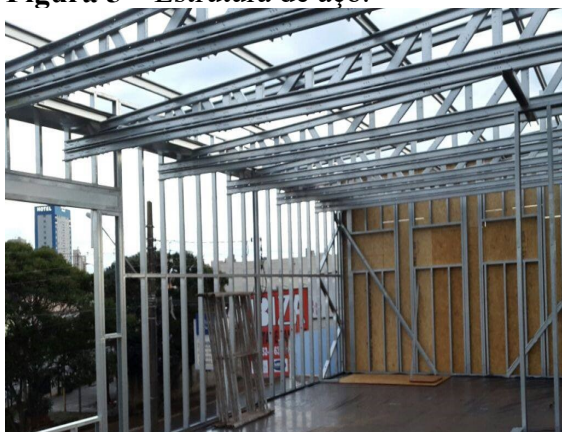
Figura 5 – Estrutura de aço.
