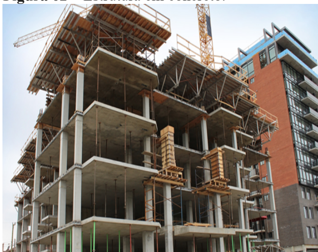
Figura 02 – Estrutura em concreto.
