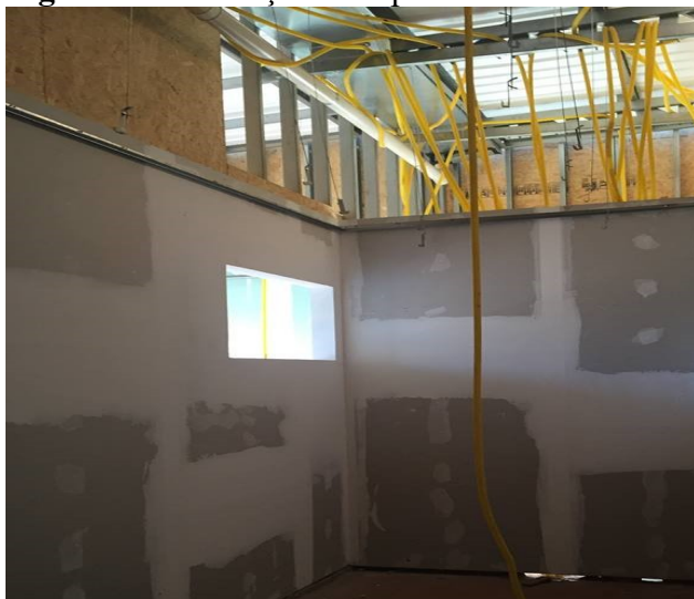
Figura 03 – Vedação com painéis.
