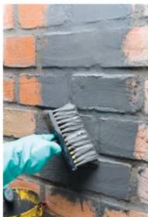
Figura 18: Aplicação de Impermeabilizante sobre superfície
