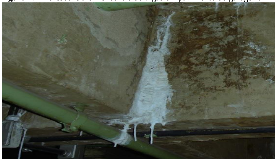
Figura 2: Eflorescência em encontro de vigas em pavimento de garagem.
