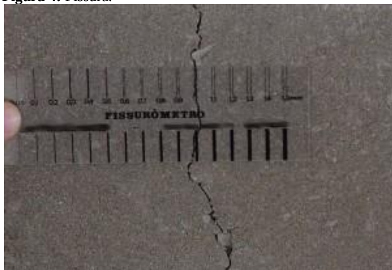
Figura 4: Fissura.
