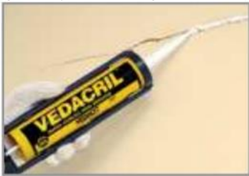
Figura 12: Correção de fissuras com mástique de acrílico Vedacril.
