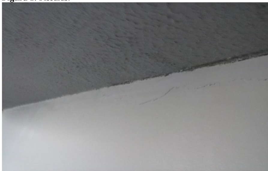
Figura 1: Fissuras.
