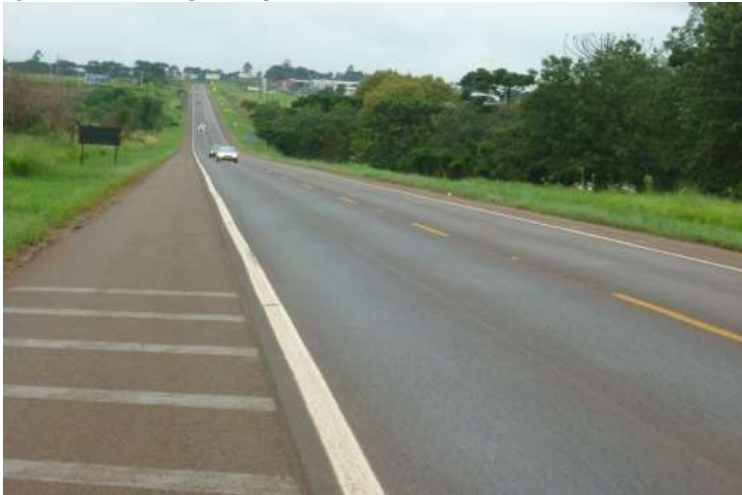
Figura 1: Rodovia em pista simples.
