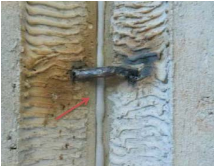
Figura 15: Posicionamento do cordão de polietileno e aplicação da argamassa AC III
