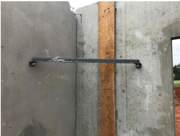
Figura 28: Travas provisórias
