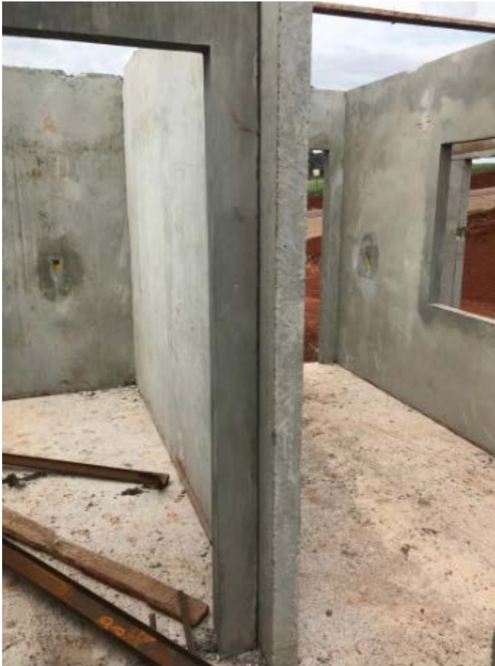
Figura 27: Paredes em suas posições definitivas
