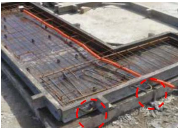
Figura 6: Detalhe das alças de içamento.
