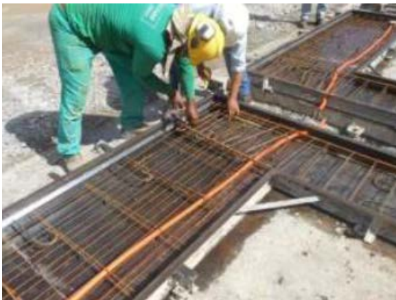
Figura 5: Reforços em barras de aço CA 50.
