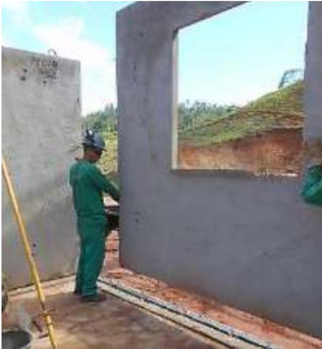
Figura 11: Demarcação e aplicação da argamassa de assentamento
