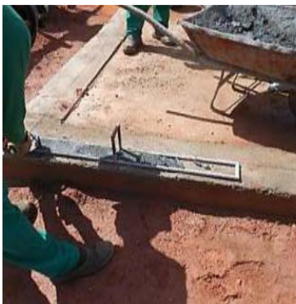
Figura 10: Demarcação e aplicação da argamassa de assentamento
