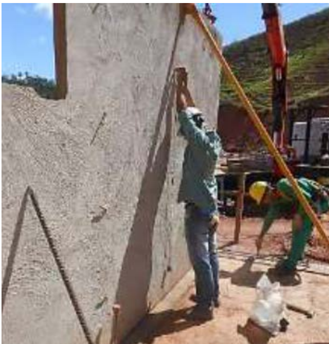
Figura 12: Verificação do prumo e escoramento do painel
