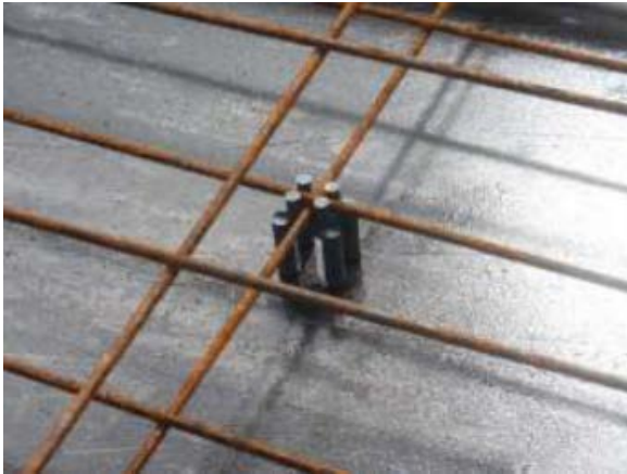
Figura 4: Detalhe distanciadores plásticos.
