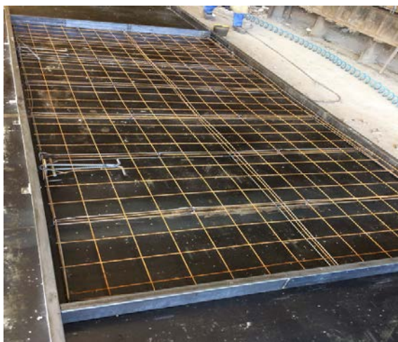
Figura 21: Armadura posicionada na fôrma
