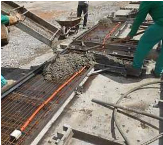
Figura 7: Lançamento, espalhamento e adensamento do concreto
