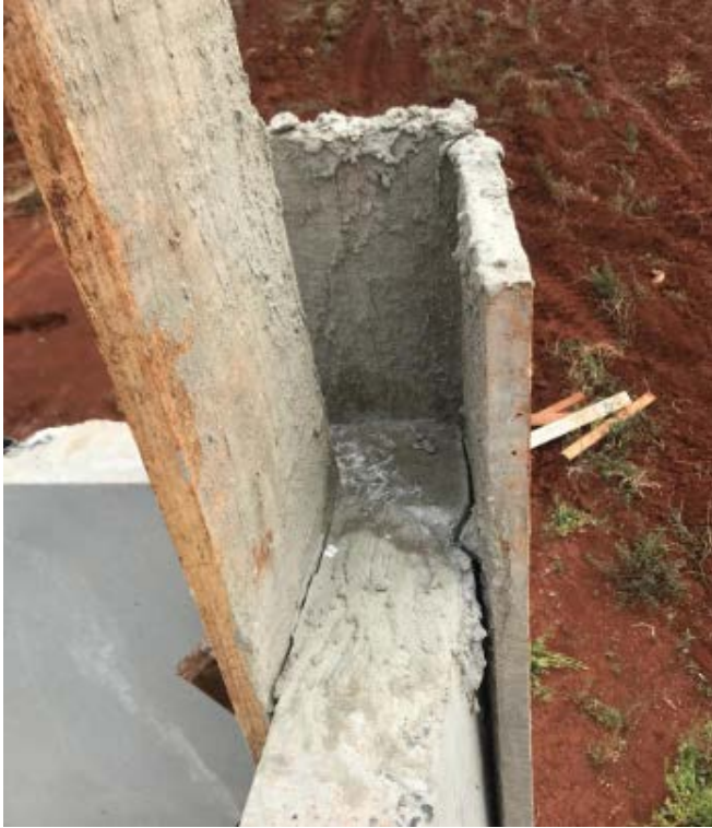
Figura 30: Vedação e união das paredes com a utilização de argamassa
