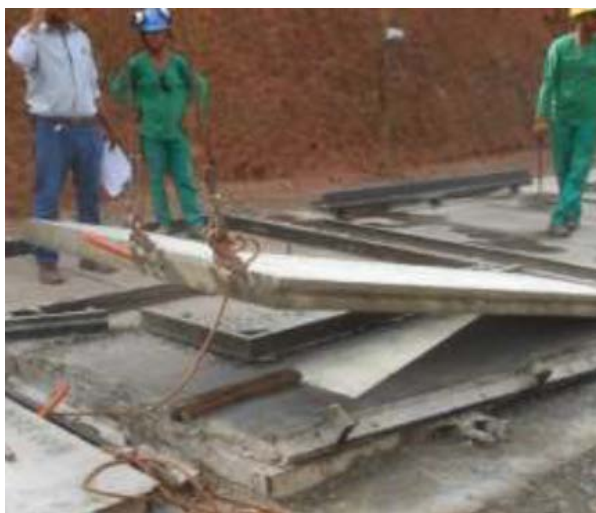
Figura 8: Içamento dos elementos em concreto
