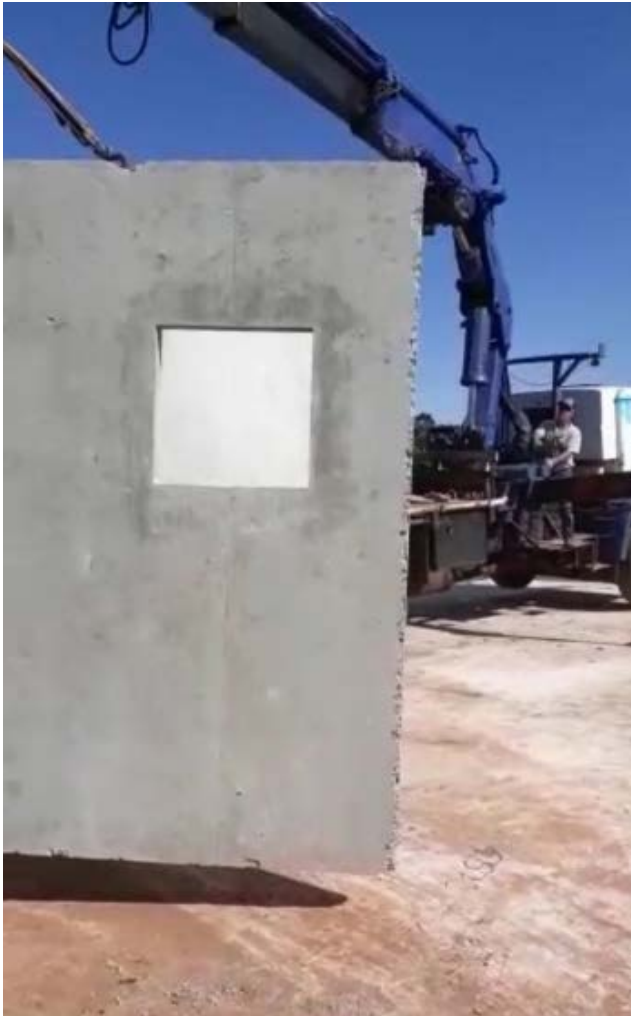
Figura 26: Peças sendo montadas
