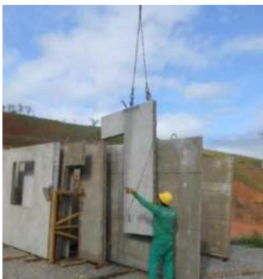
Figura 9: Estocagem vertical dos elementos em concreto
