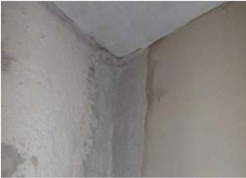
Figura 17: Tratamento das juntas verticais internas
