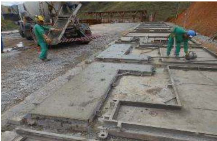
Figura 1: Vista geral da fabricação das paredes em concreto armado
