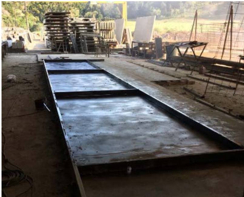
Figura 20: Fôrma horizontal de paredes
