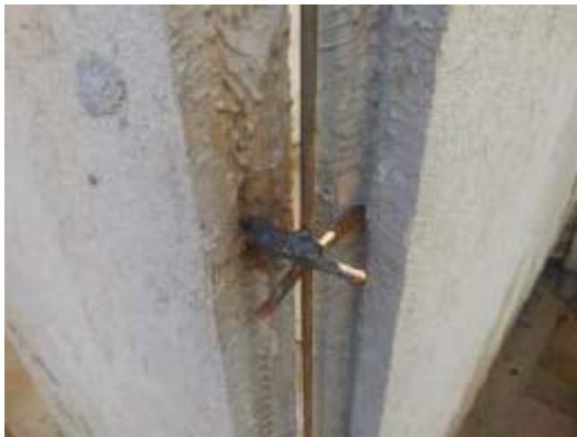
Figura 14: Solda das barras de aço nas paredes externas
