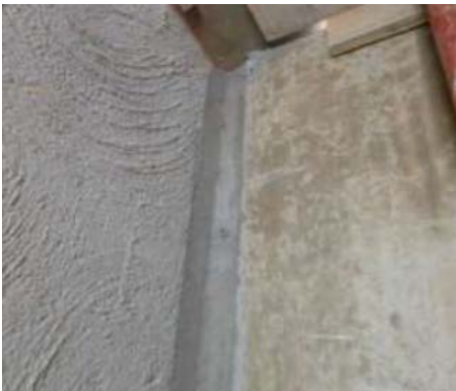
Figura 16: Preenchimento das juntas das paredes com graute
