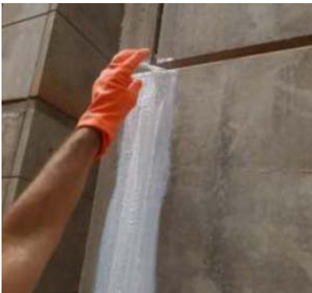
Figura 18: Acabamento das juntas verticais externas
