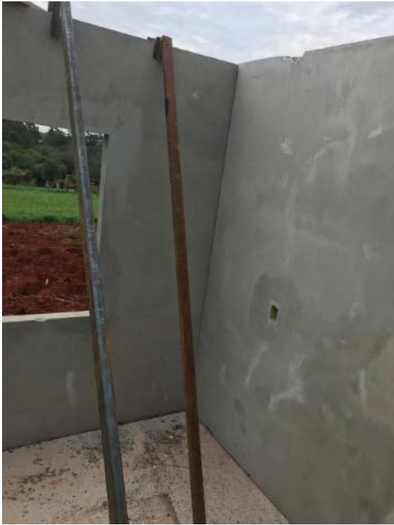
Figura 29: Escoramentos provisórios
