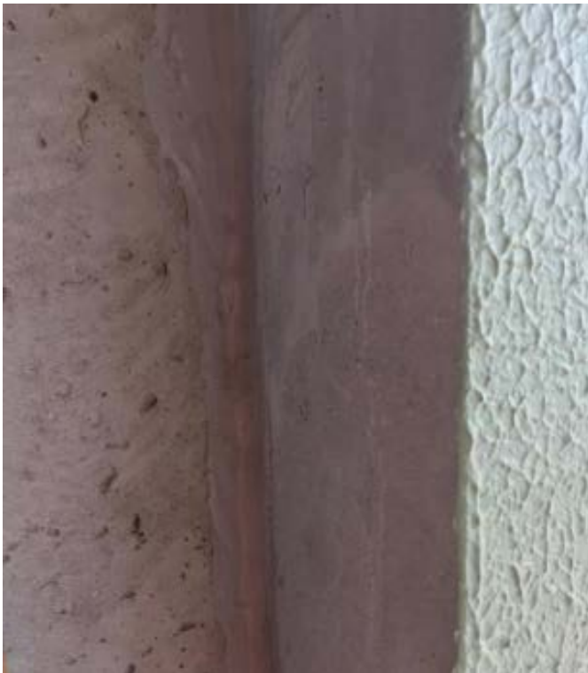
Figura 31: Acabamento com a utilização de selante de poliuretano
