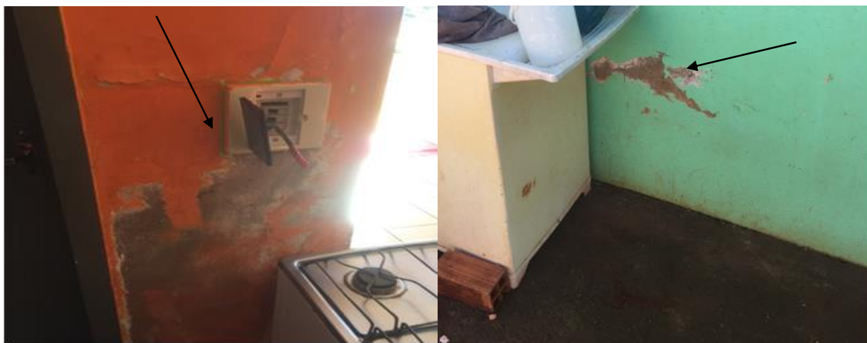
Figura 12- Desagregação das camadas externas e da película da tinta
