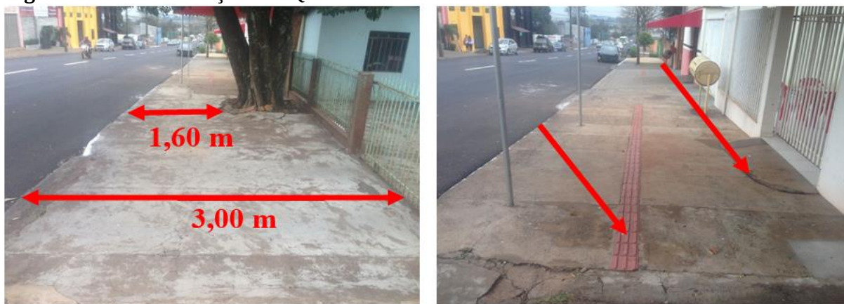
Figura 60: Parte de calçada da Quadra 209 C
