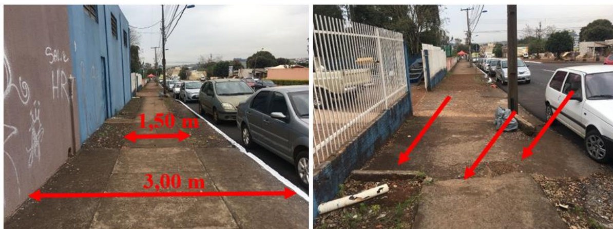
Figura 56: Estreitamento da calçada na Quadra 34
