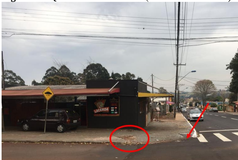
Figura 50: Quadra 06 – Trecho 02 (sentido sul → norte)
