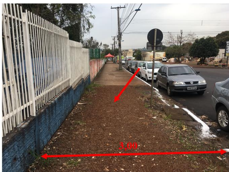
Figura 57: Estreitamento da calçada na Quadra 34
