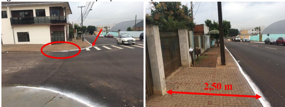
Figura 38: Inexistência de rampa e piso tátil na Quadra 05
