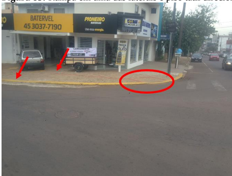
Figura 85: Rampa em uma das laterais e piso tátil direcional em parte da calçada
