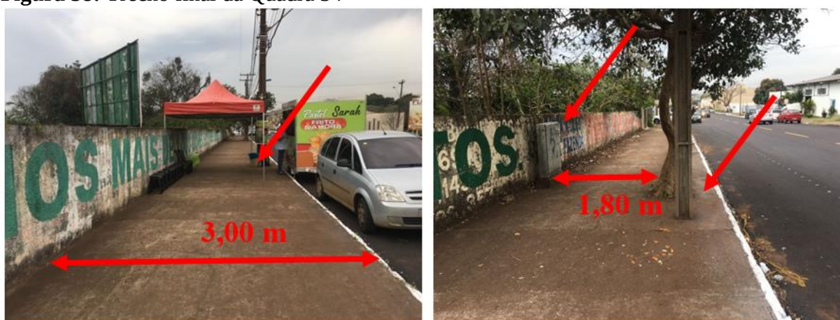
Figura 58: Trecho final da Quadra 34
