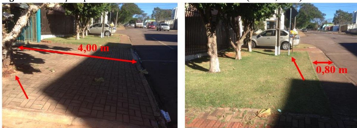
Figura 106: Calçada parcialmente em acordo com a NBR 9050 (ABNT, 2015)
