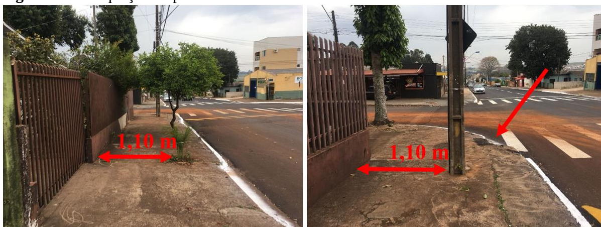
Figura 40: Adequação de piso tátil de alerta em áreas de obstáculos
