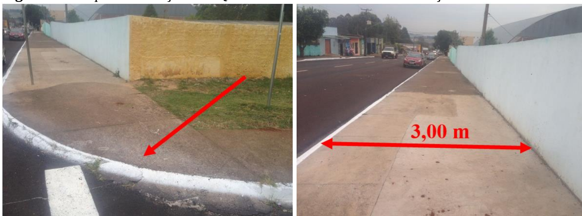
Figura 45: Esquina da calçada da Quadra 209B e continuidade da calçada
