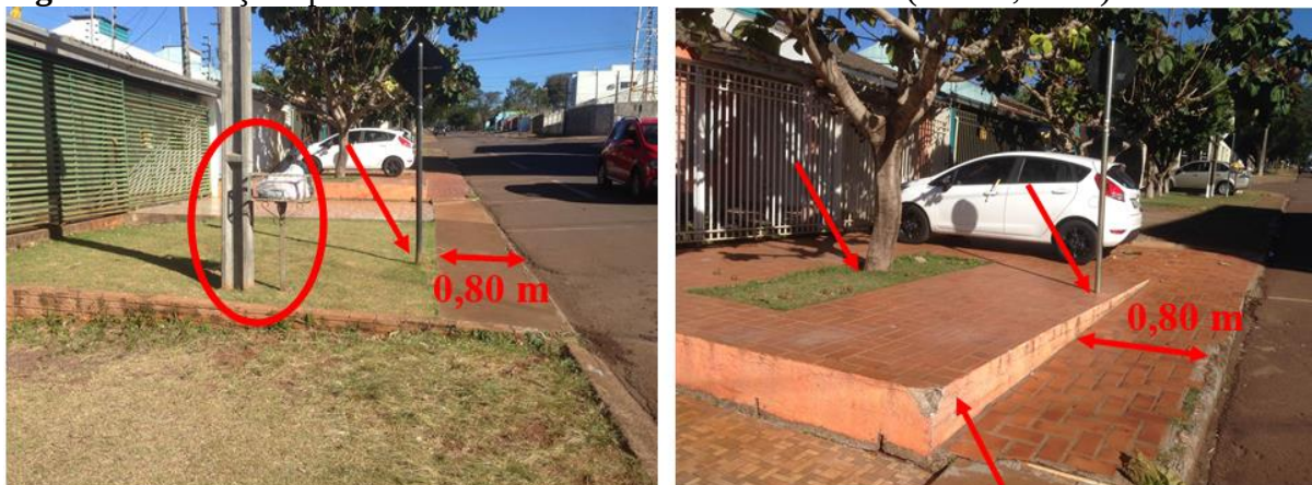
Figura 105: Calçada parcialmente em acordo com a NBR 9050 (ABNT, 2015)
