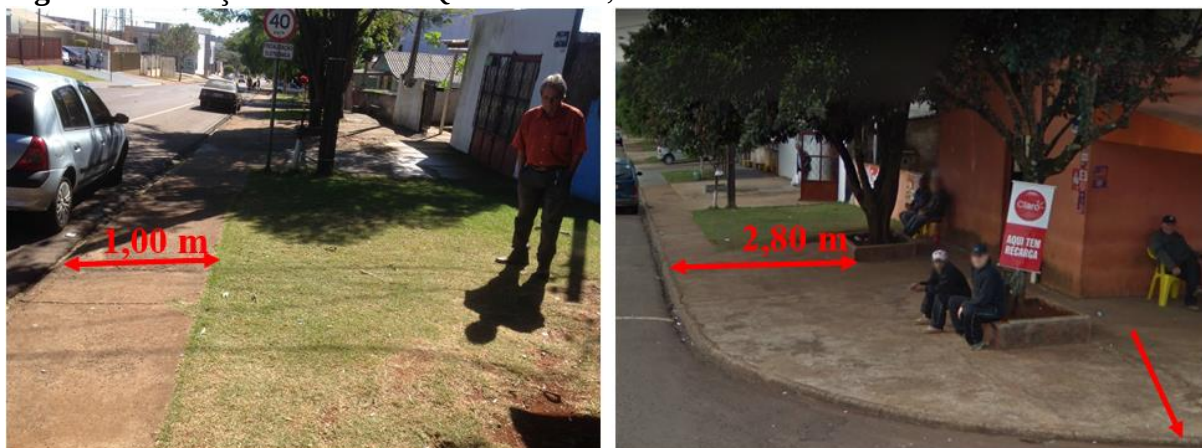
Figura 111: Calçada ao final da Quadra 210 C, no Trecho 4
