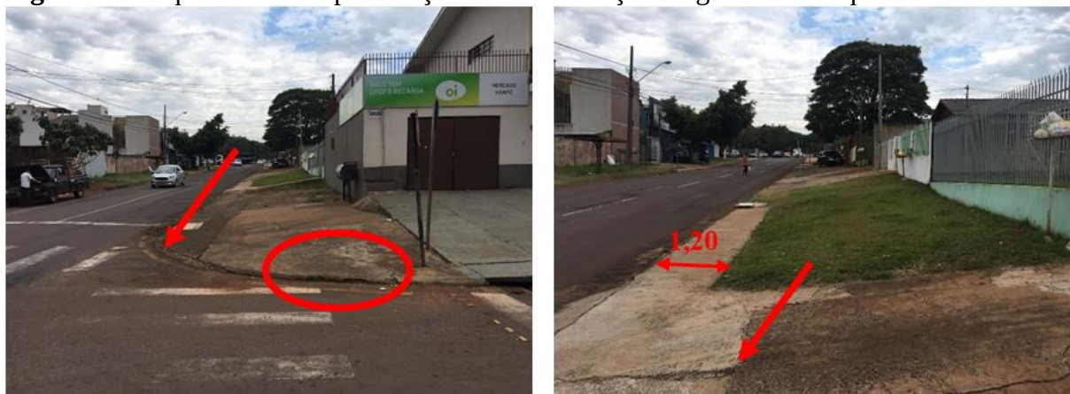
Figura 74: Esquina sem rampa e calçada com inclinação longitudinal adequada
