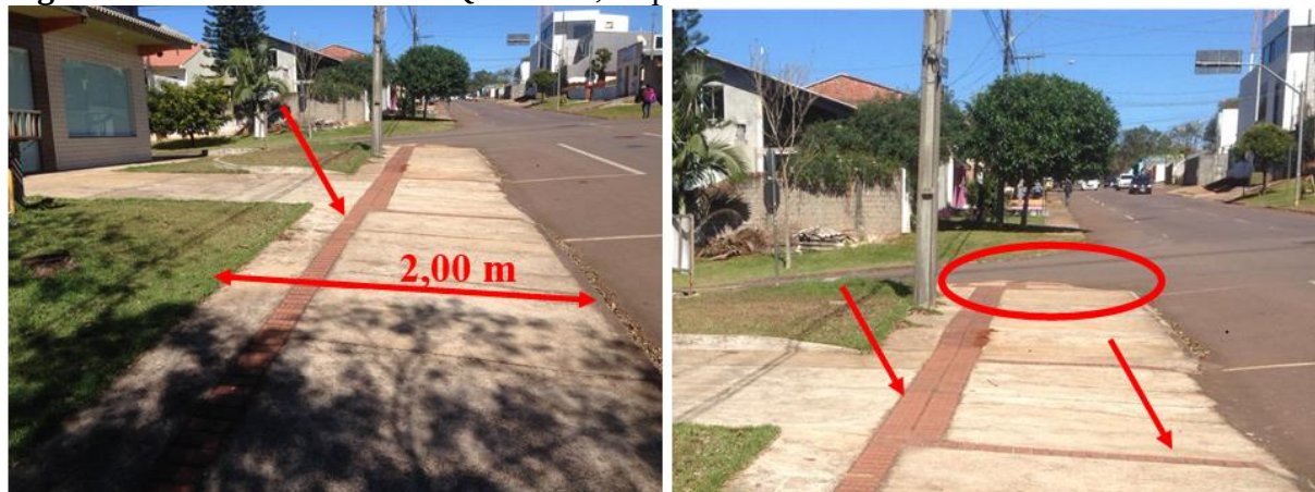
Figura 102: Final do trecho da Quadra 32, esquina com Rua Alcir da Mota
