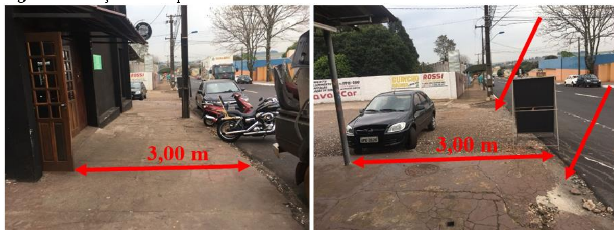
Figura 54: Calçada inadequada no Trecho 2
