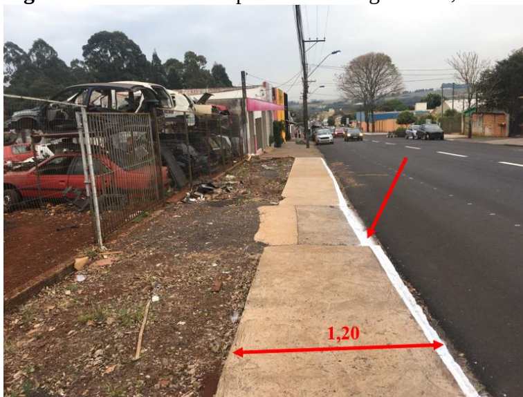
Figura 52: Revestimento parcial com largura de 1,20 metros
