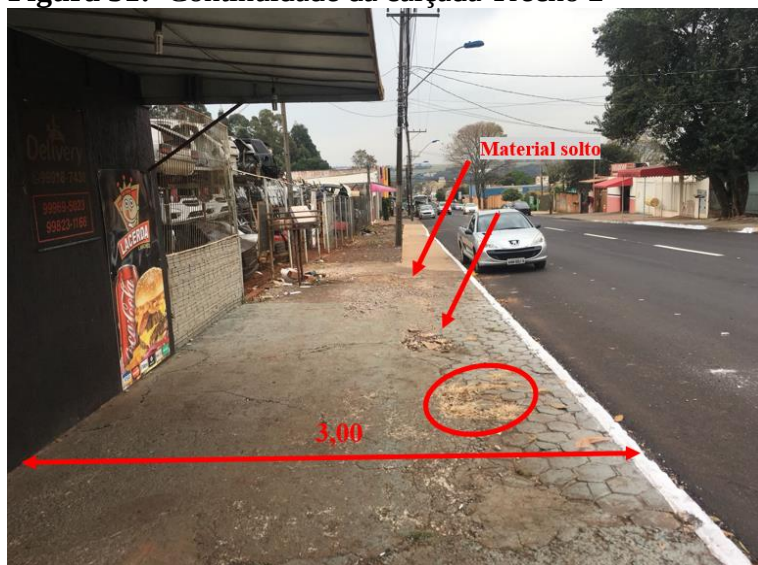
Figura 51: Continuidade da calçada Trecho 2
