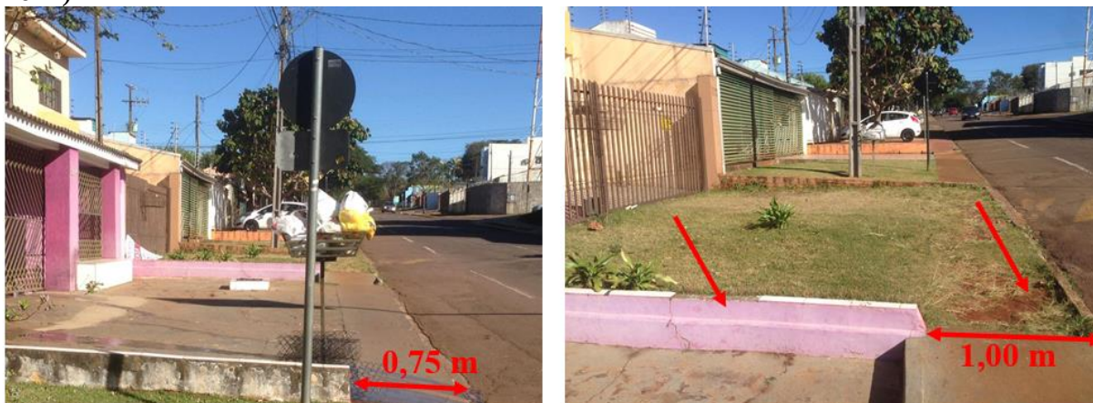
Figura 104: Calçada em desacordo com a NBR 9050 (ABNT, 2015) e a Lei nº 5.744 (Cascavel, 2011)
