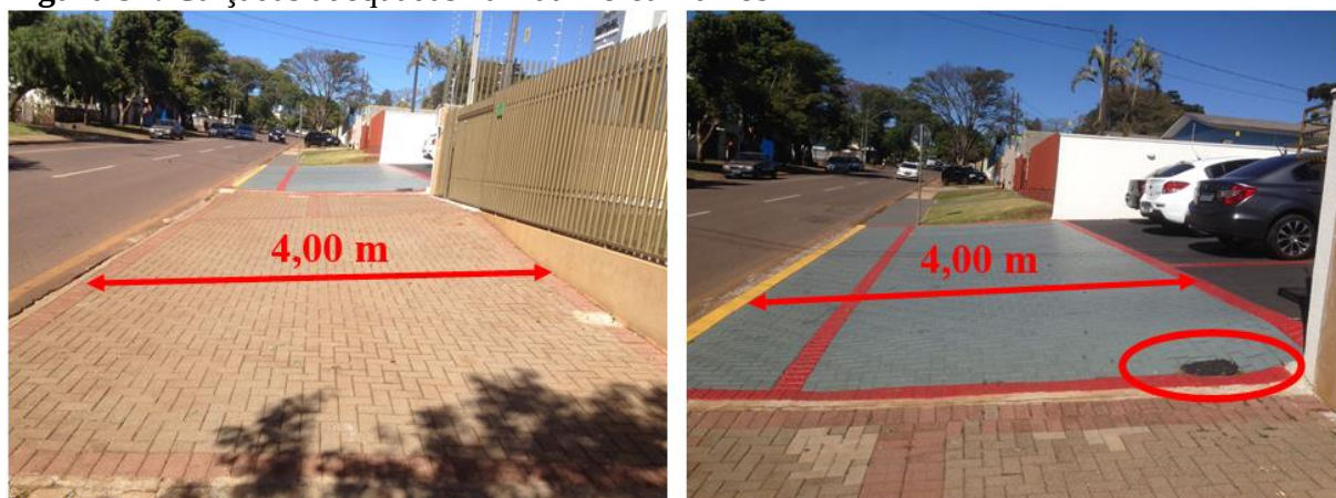
Figura 97: Calçadas adequadas na Rua Nereu Ramos
