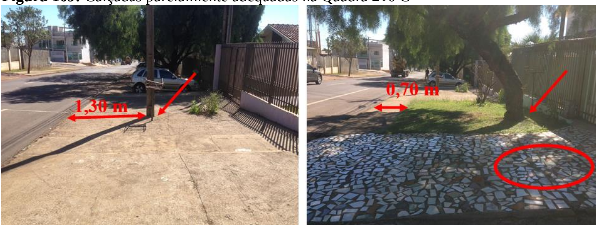
Figura 109: Calçadas parcialmente adequadas na Quadra 210 C
