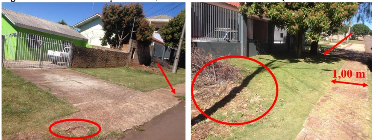
Figura 101: Revestimento parcial de 1,00 metro nos lotes centrais da Quadra 32
