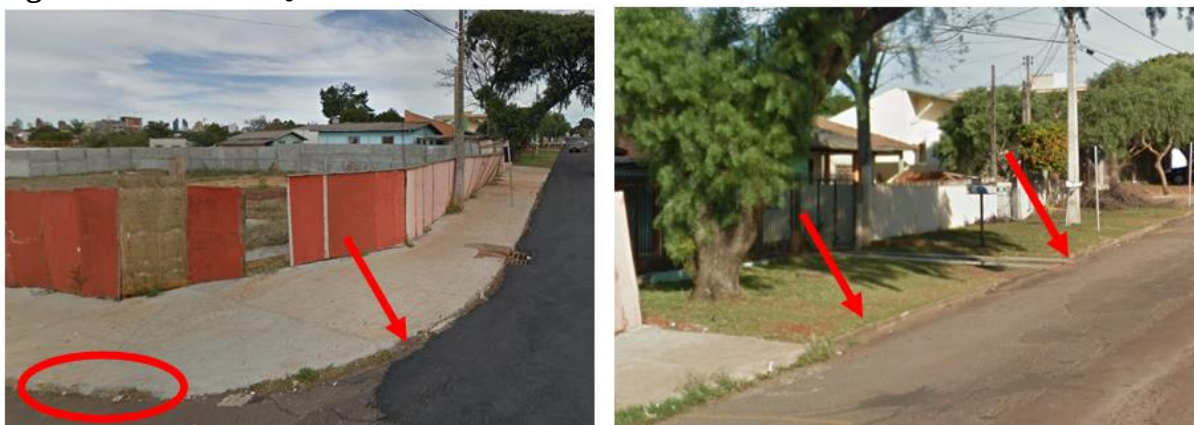
Figura 78: Início da Quadra 209 B do trecho 03
