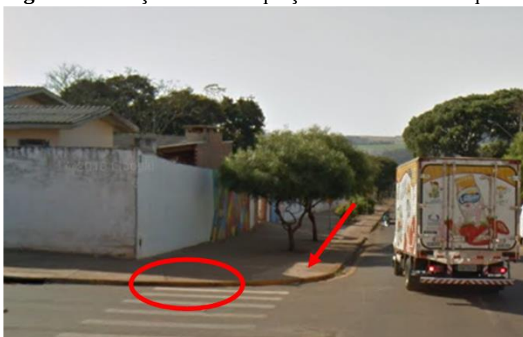
Figura 73: Calçada sem adequações de acesso na esquina
