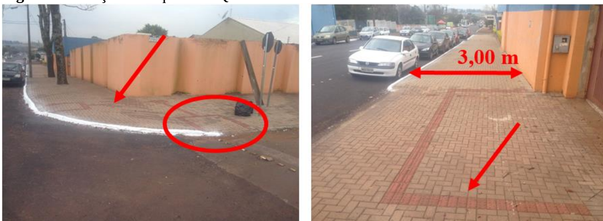
Figura 63: Calçada e esquina da Quadra 35
