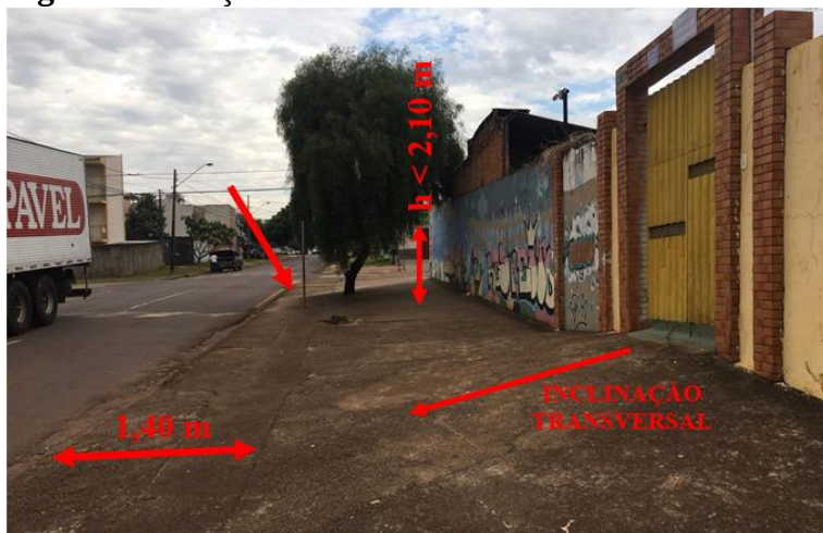
Figura 72: Calçada de acesso à escola
