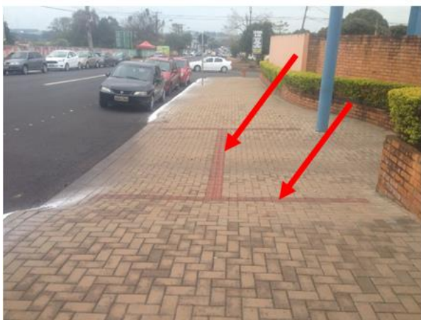
Figura 64: Piso tátil de alerta e direcional aplicado na Quadra 35
