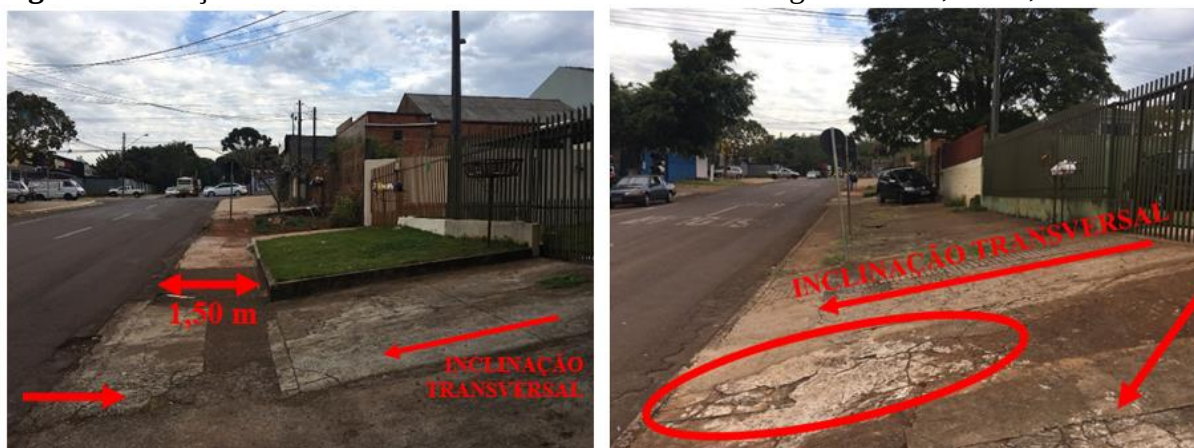
Figura 75: Calçada revestimento em cimento alisado com largura entre 1,20 e 1,50 metros
