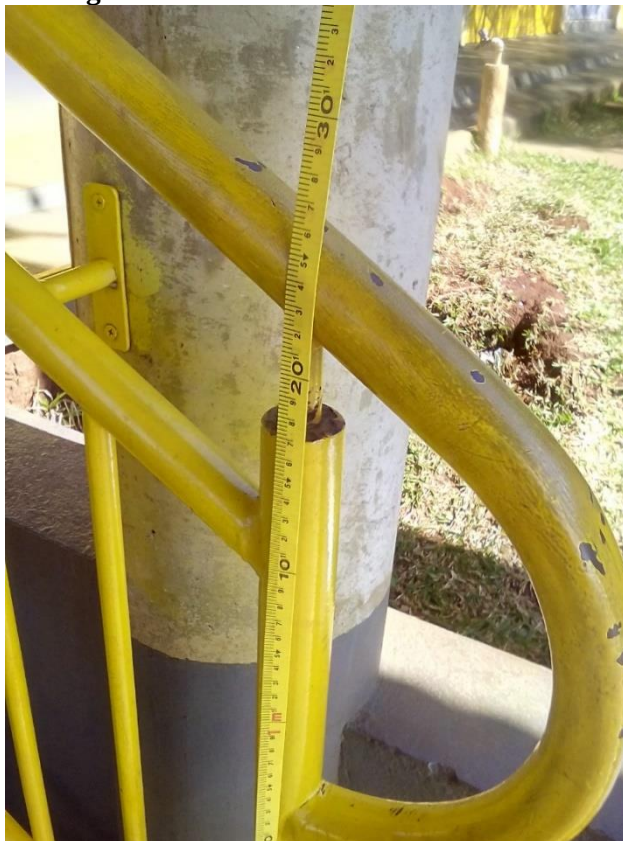
Figura 3: Corrimão da escada na entrada
