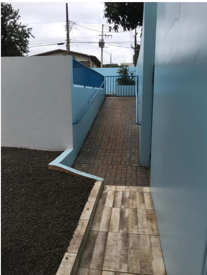
Figura 02: Rampa de acesso ao estacionamento
