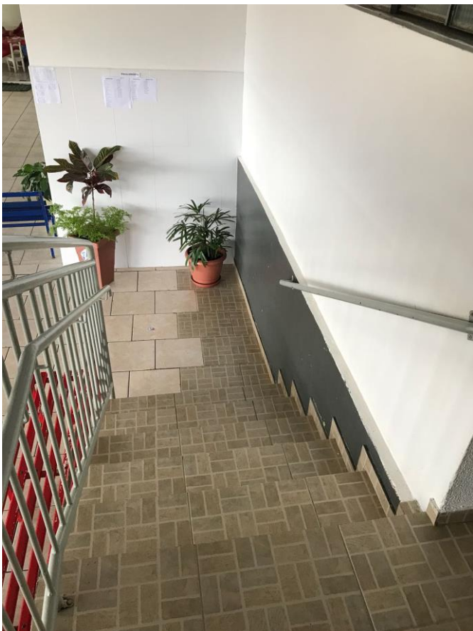
Figura 10: Detalhamento de corrimão de acesso a salas de aula, ginásio e banheiros
