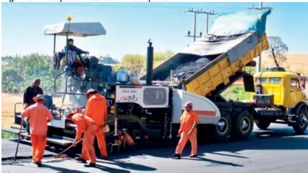
Figura 3: Execução de mistura asfáltica a quente.
