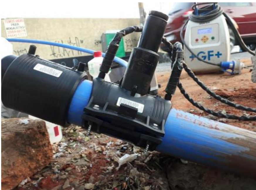
Figura 4: Mecanismo de junta de eletrofusão
