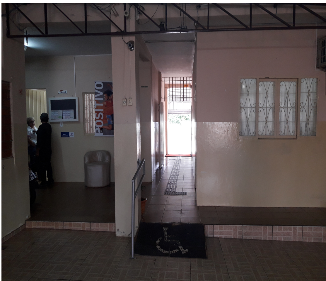
Figura 30: Interior da edificação.
