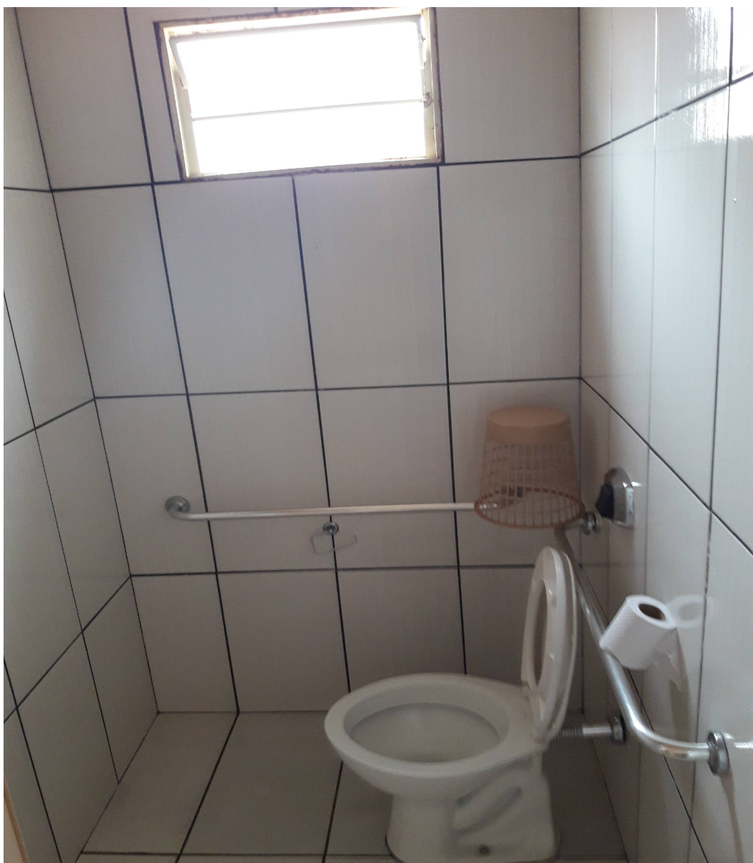
Figura 34: Banheiro acessível feminino.
