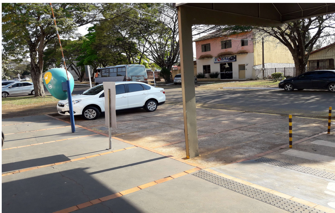
Figura 27: Entrada da edificação 01.
