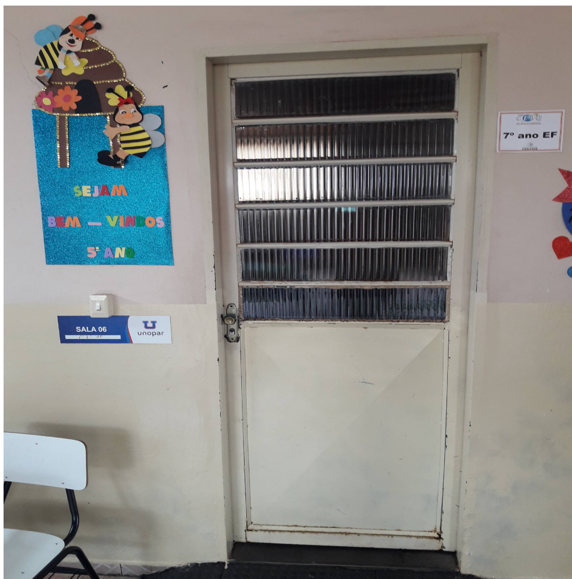
Figura 31: Porta presente no interior da edificação.
