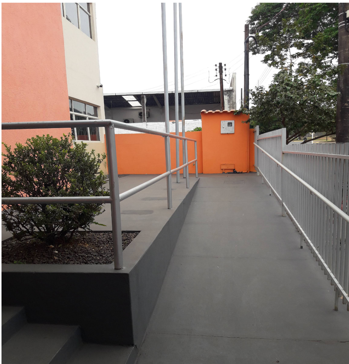
Figura 33: Rampa de acesso principal.
