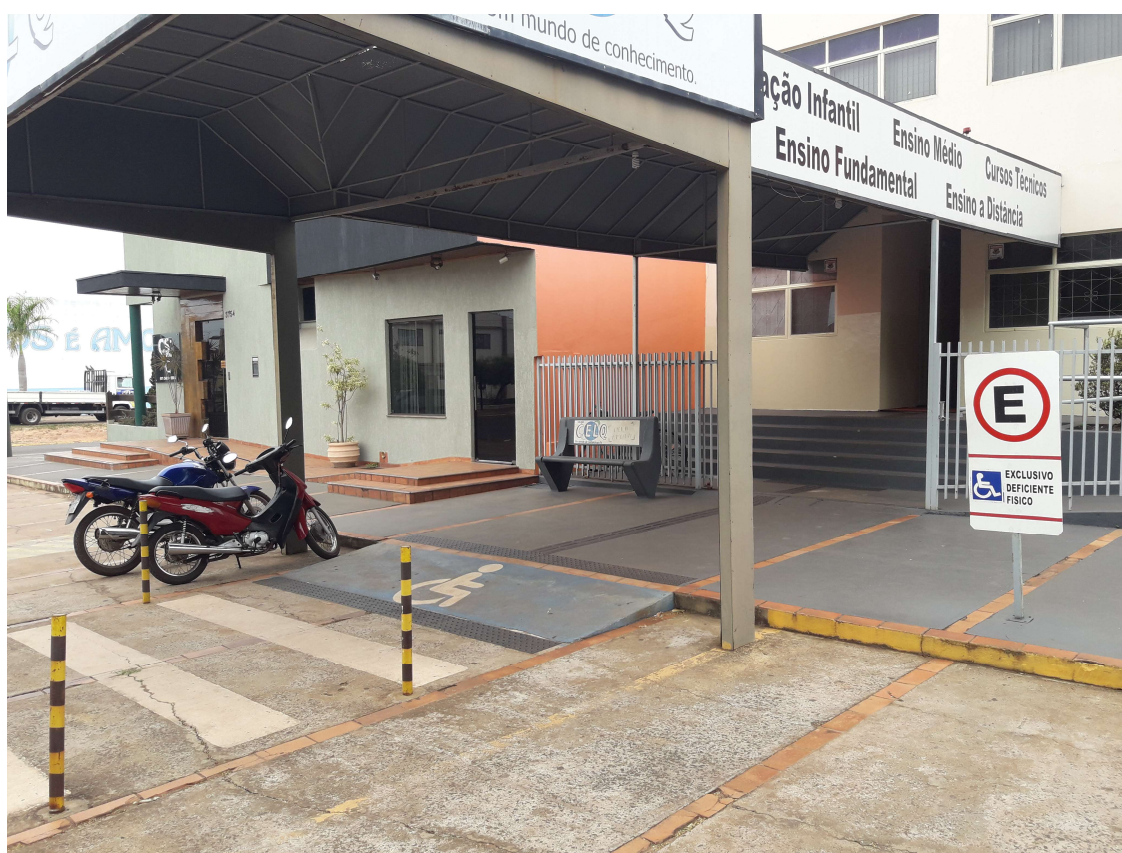
Figura 29: Entrada da edificação 03.
