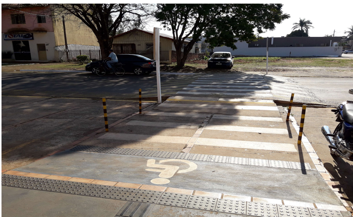
Figura 28: Entrada da edificação 02.
