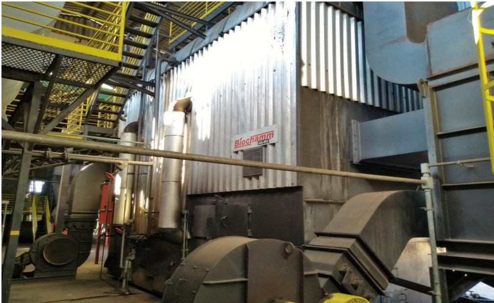
Figura 30: Caldeira Mista Utilizada no Estudo
