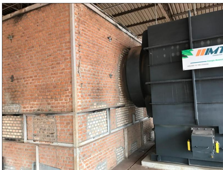
Figura 12: Adequação na fornalha de alvenaria
