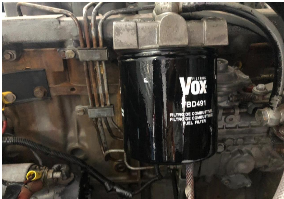
Figura 11 – Substituição do filtro de combustível.
