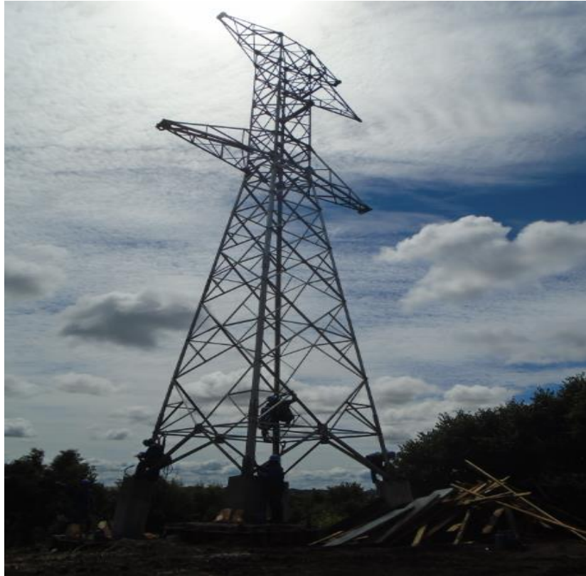
Figura 8 - torre autoportante em fase final de montagem, com atividade de revisão sendo executada.
