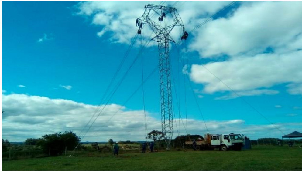
Figura 17 - atividade de regulagem e grampeamento de cabos sendo executadas durante a montagem de uma linha de transmissão.
