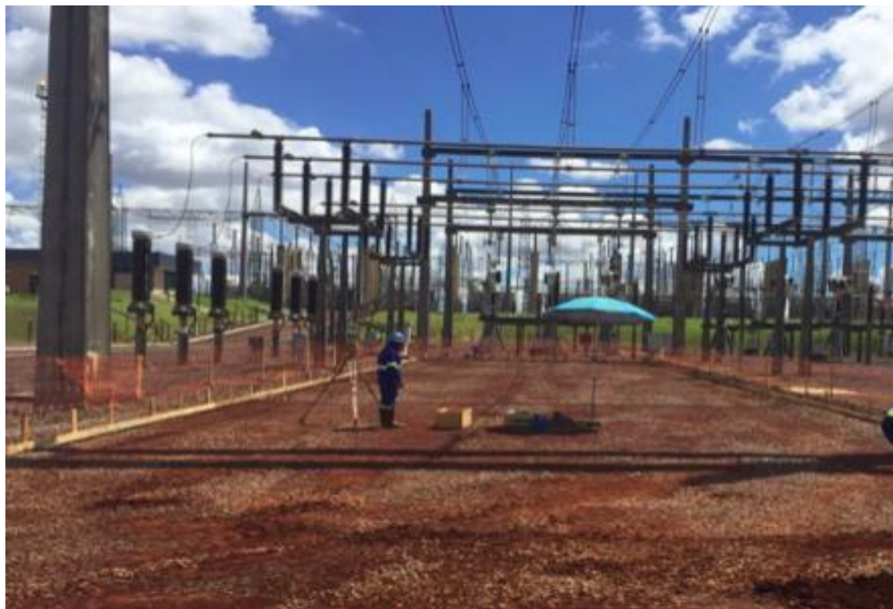
Figura 2 - Locação topográfica de estrutura de uma linha de transmissão dentro de uma subestação
