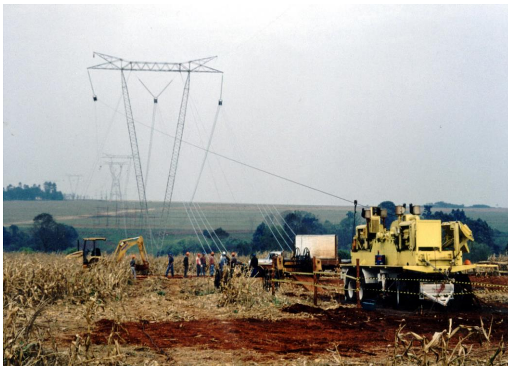
Figura 14 - lançamento de cabos condutores em linha de transmissão através da utilização de guincho.
