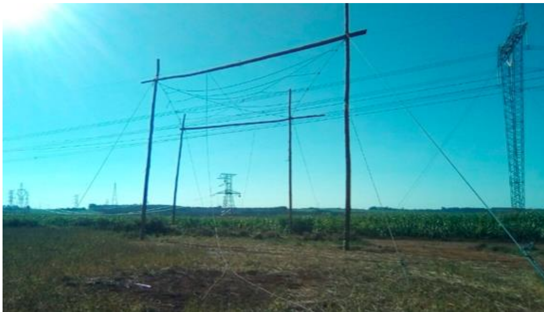
Figura 15 - exemplo de praça de lançamento de cabos. Fonte: Odebrecht – Documentos internos.
