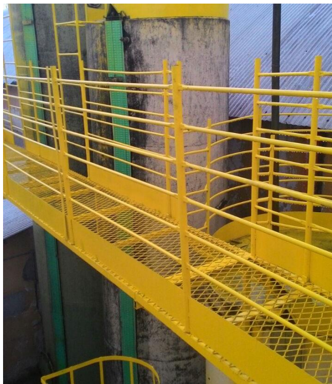
Foto 4 – Exemplo de guarda-corpo em uma estrutura de passarela
