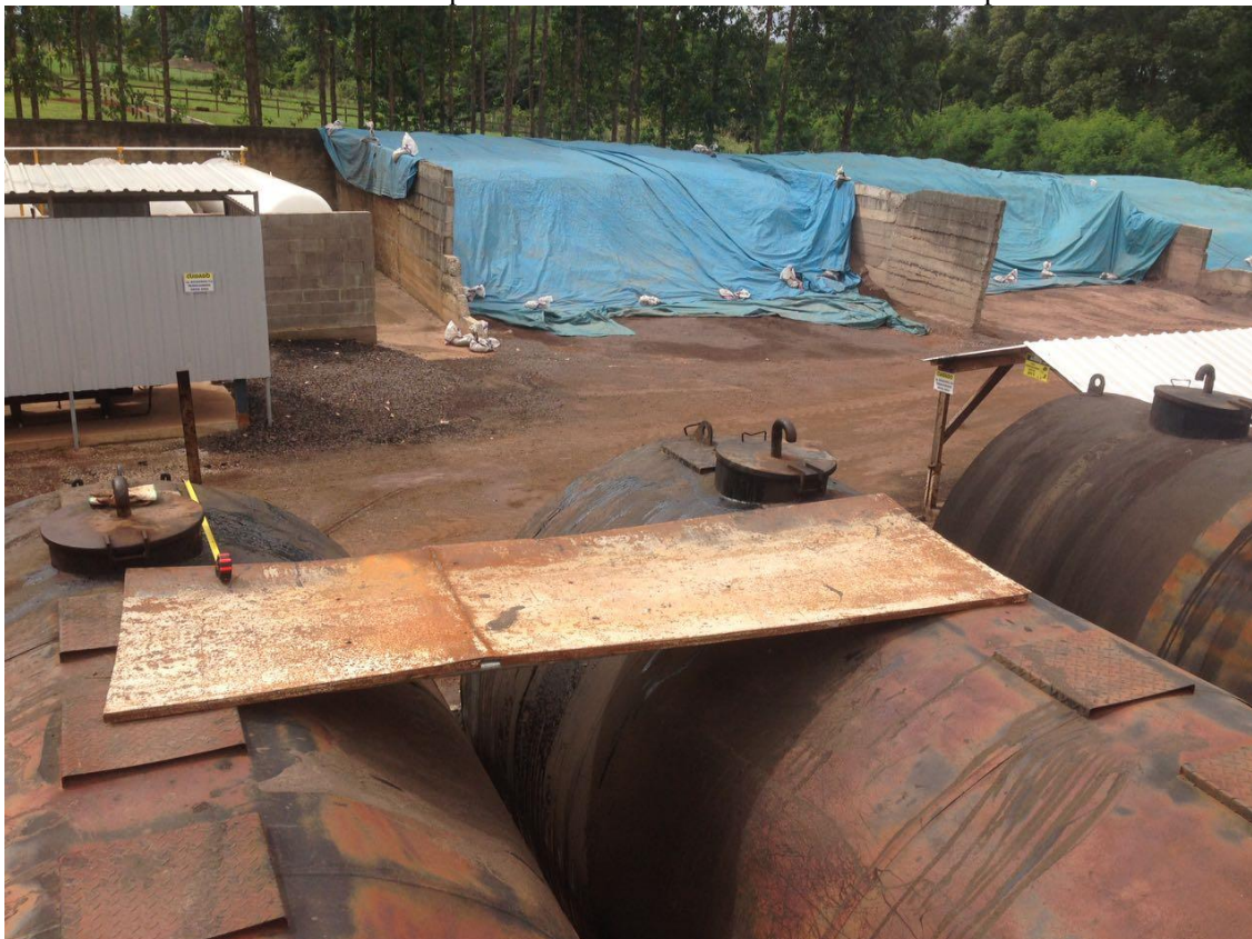
Foto 3 – Passarela improvisada utilizada na usina de asfalto da Empresa E
