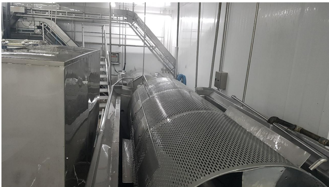
Figura 10 – Chillers de tingimento.
