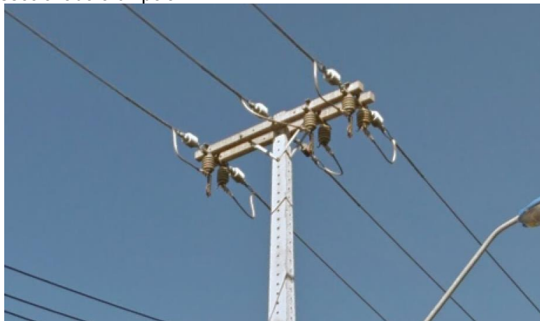
Figura 2.8 Chave seccionadora unipolar.
