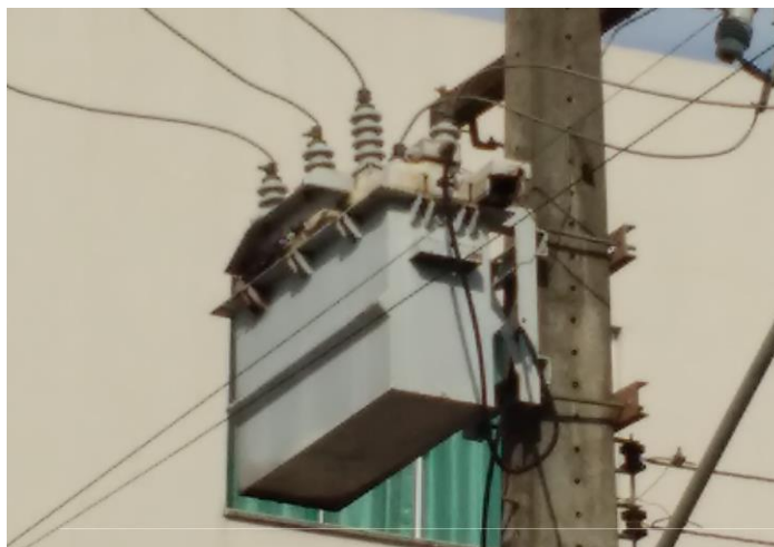
Figura 2.7 Religador automático.
