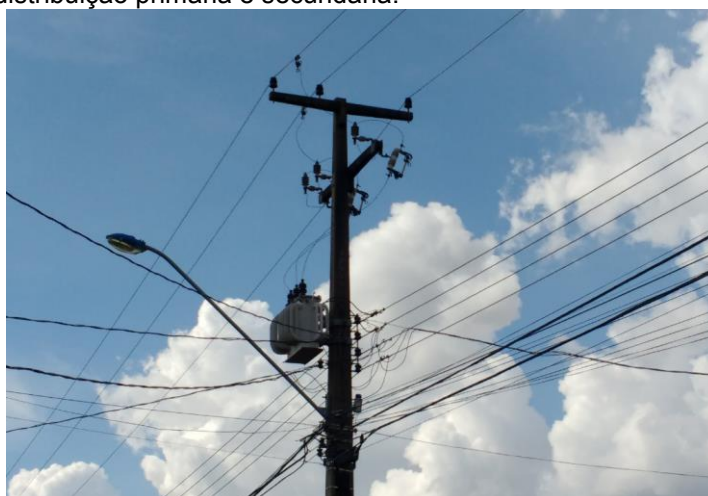
Figura 2.2 Rede de distribuição primária e secundária.
