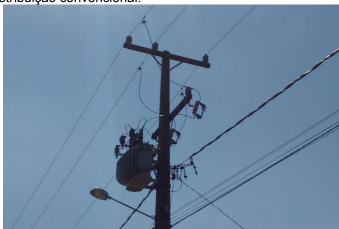
Figura 2.4 Rede de distribuição convencional.
