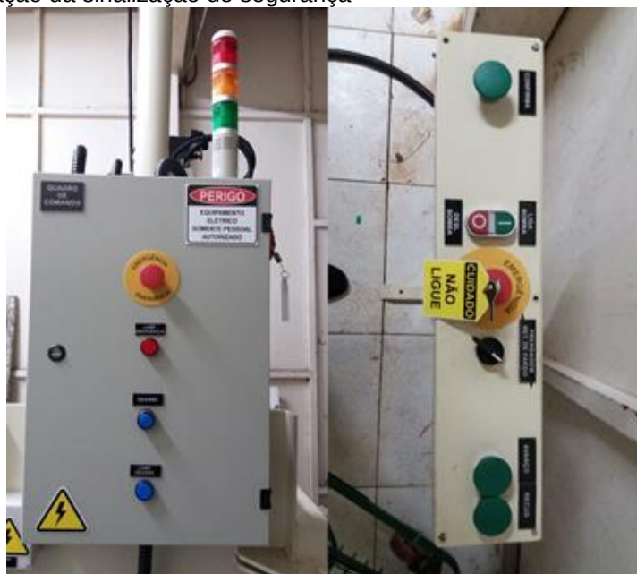
Figura 4.22 Implantação da sinalização de segurança
