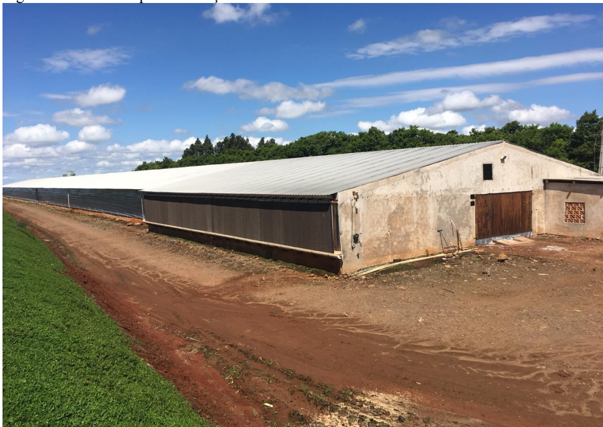
Figura 3.4 – Telhado para instalação dos módulos fotovoltaicos
