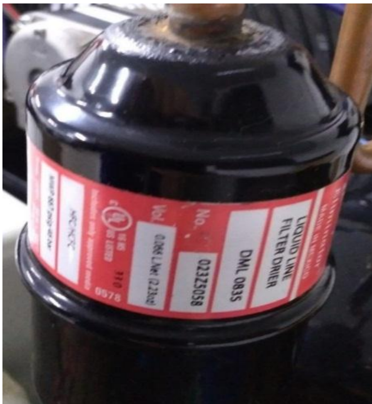
Figura 29 – Filtro secador do sistema de refrigeração.
