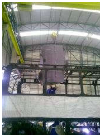
Figura 13: Inserção por meio de ponte rolante
