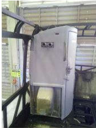
Figura 14: Sanitário no local de fixação
