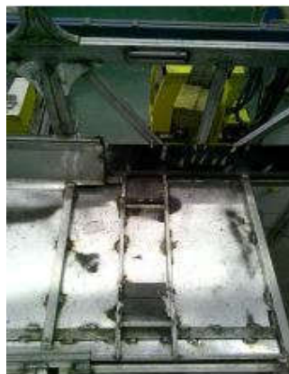
Figura 9: Alterações na base do sanitário
