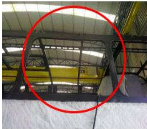
Figura 15: Recorte do teto já soldado
