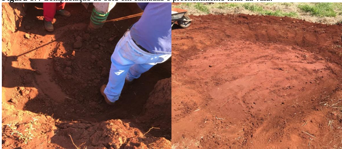
Figura 17: Compactação do solo em camadas e preenchimento total da vala.
