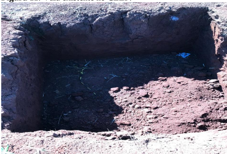
Figura 11: Vala existente no CEEF.
