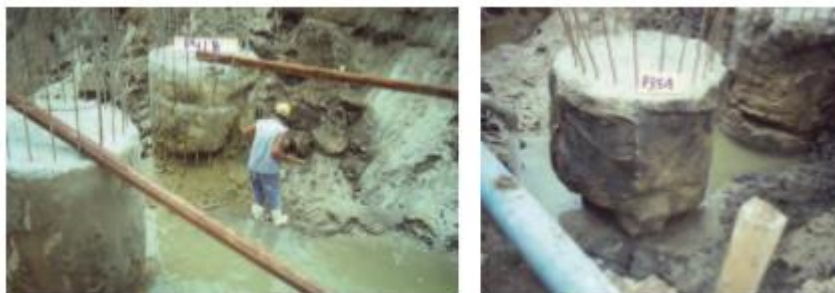
Figura 34 - Estrangulamento de Fuste
