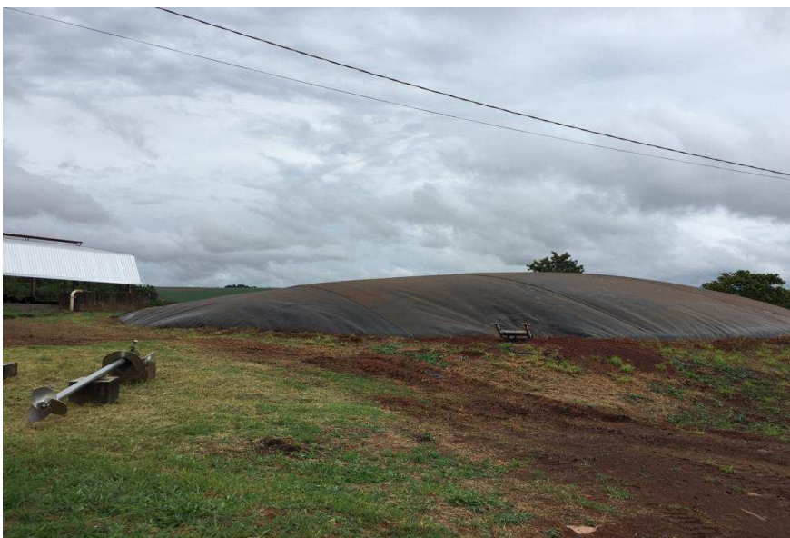
Figura 6 – Piscina do biodigestor
