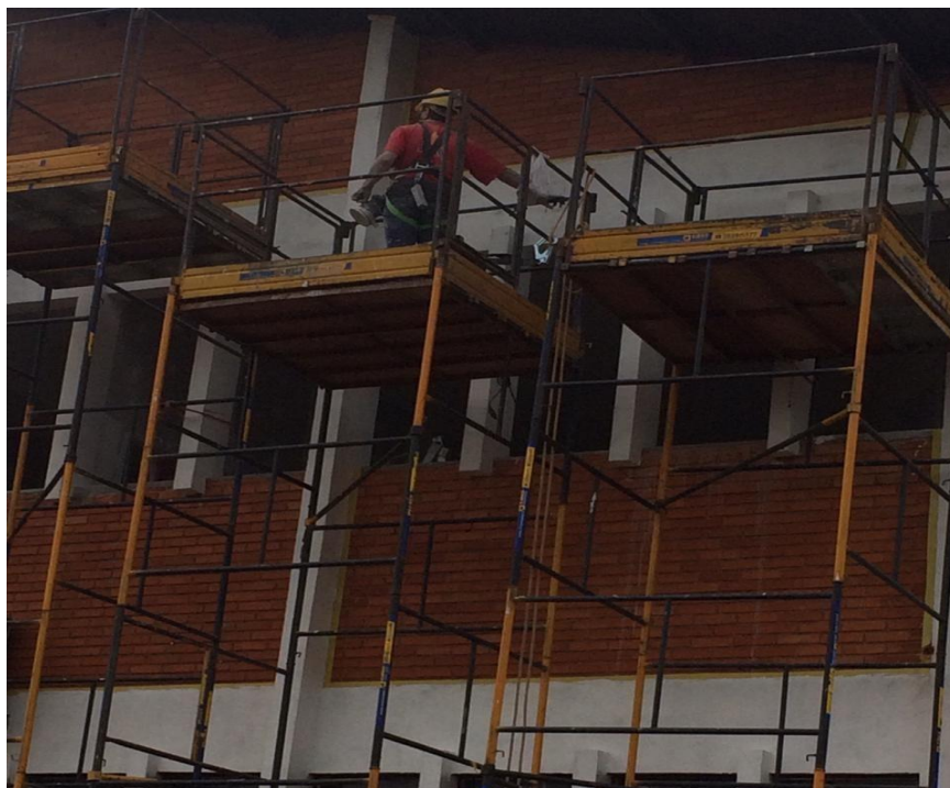
Figura 7: Trabalhador executando atividade em altura
