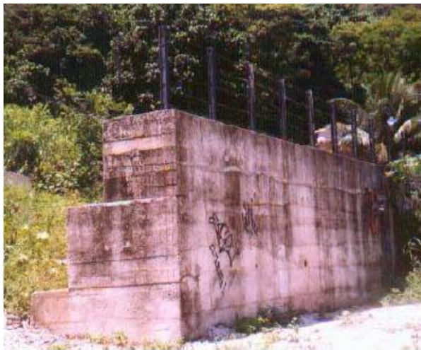
Figura 6: Muro de concreto.
