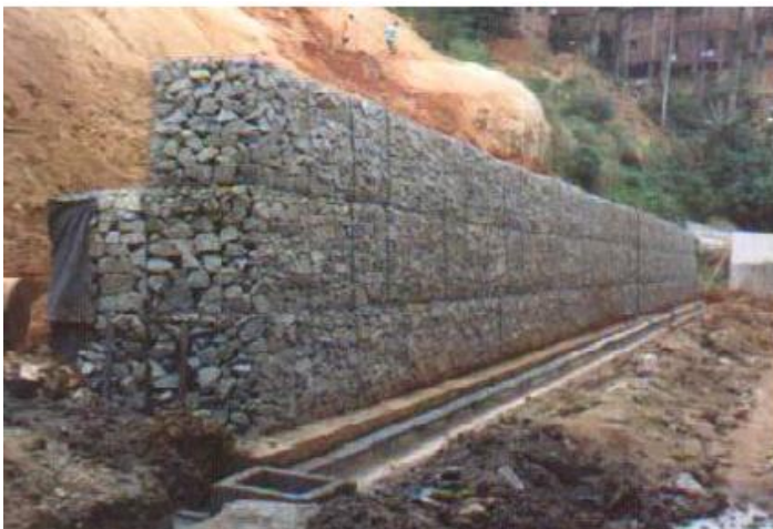
Figura 7: Muro de gravidade do tipo Gabião.
