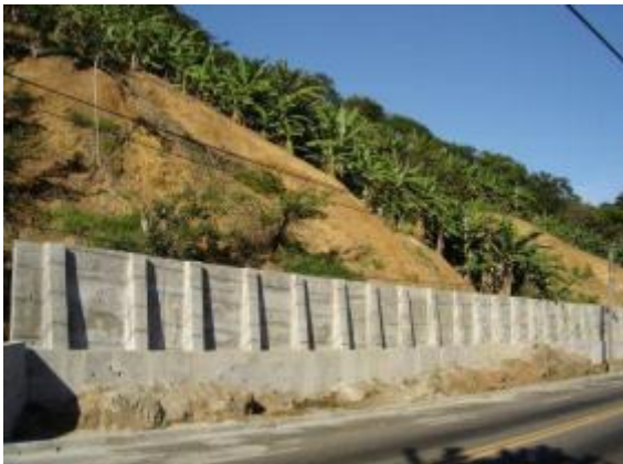
Figura 8: Muro de flexão com contraforte.
