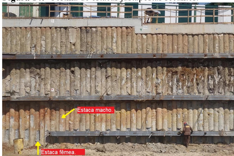
Figura 14: Cortina de estacas justapostas secantes.
