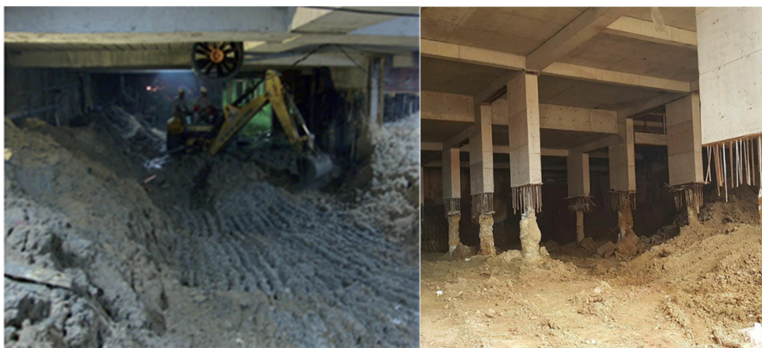
Figura 16: Escavação confinante sendo realizada para posterior realização da laje do seguinte subsolo.
