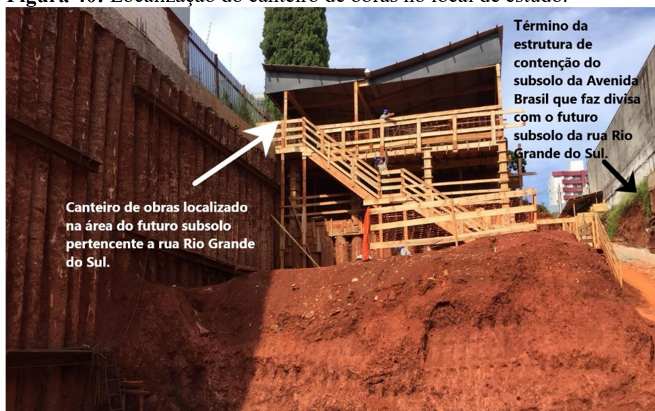
Figura 40: Localização do canteiro de obras no local de estudo.
