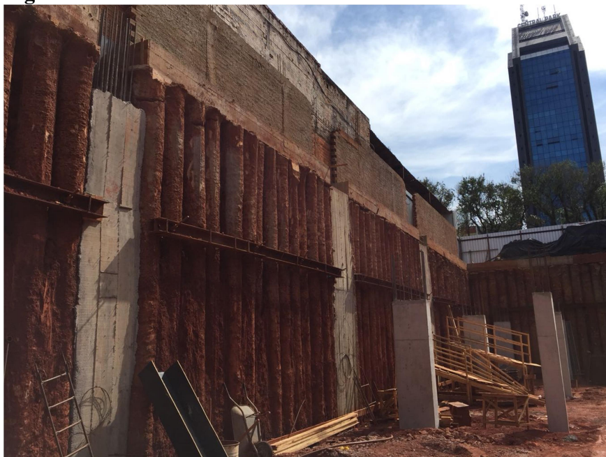
Figura 25: Cortinas de estacas realizada no local de estudo.
