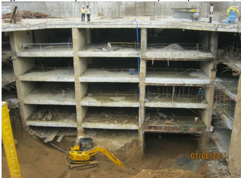
Figura 17: Escavação confinante e avanço da superestrutura, executadas simultaneamente.
