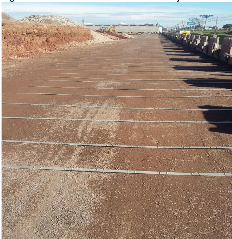
Figura 25: Fitas metálicas colocadas na construção da terra armada.
