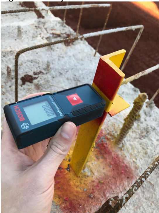
Figura 38: Aferição das distâncias horizontais com trena a laser.
