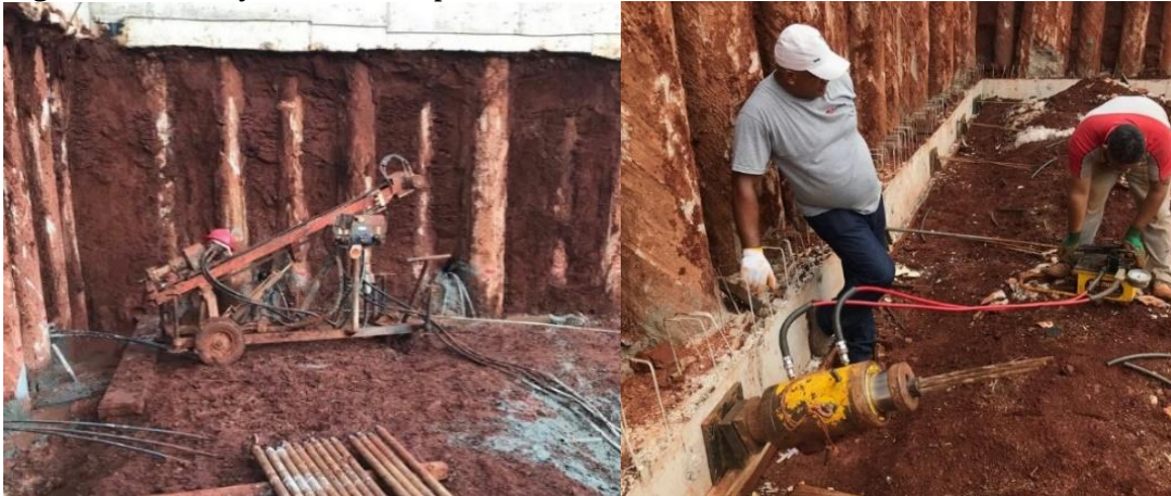
Figura 23: Execução dos furos e protensão dos tirantes.
