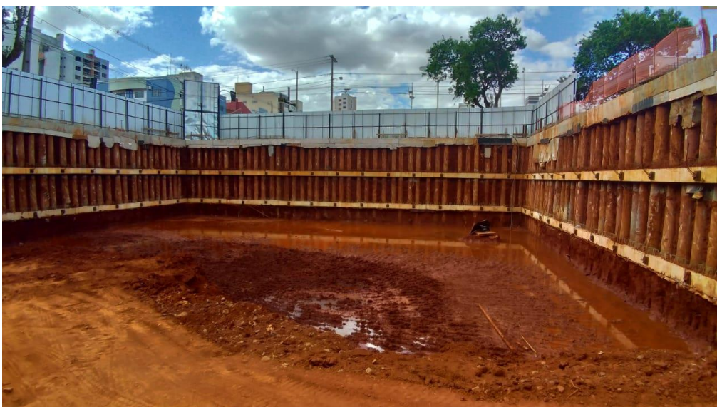
Figura 24: Escavação do terceiro subsolo.
