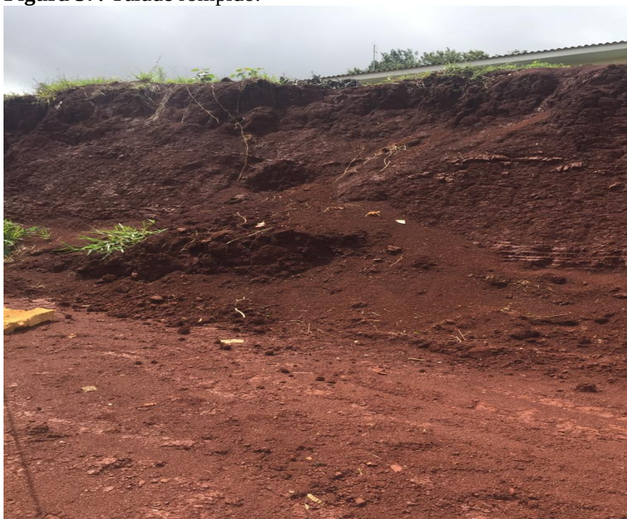
Figura 37: Talude rompido.
