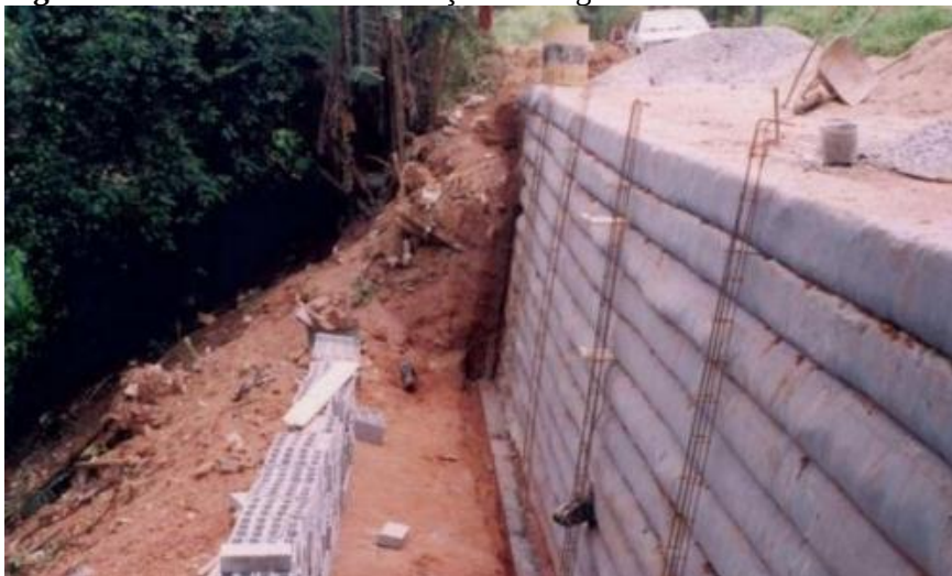
Figura 24: Talude com solo reforçado com geotêxtil.
