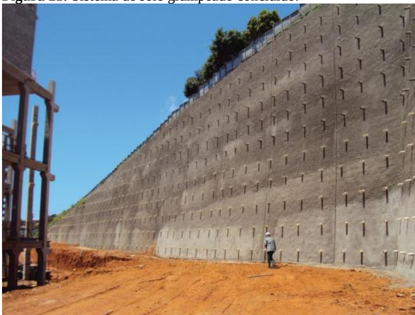
Figura 21: Sistema de solo grampeado concluído.
