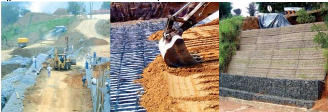
Figura 23: Processo executivo do solo reforçado.
