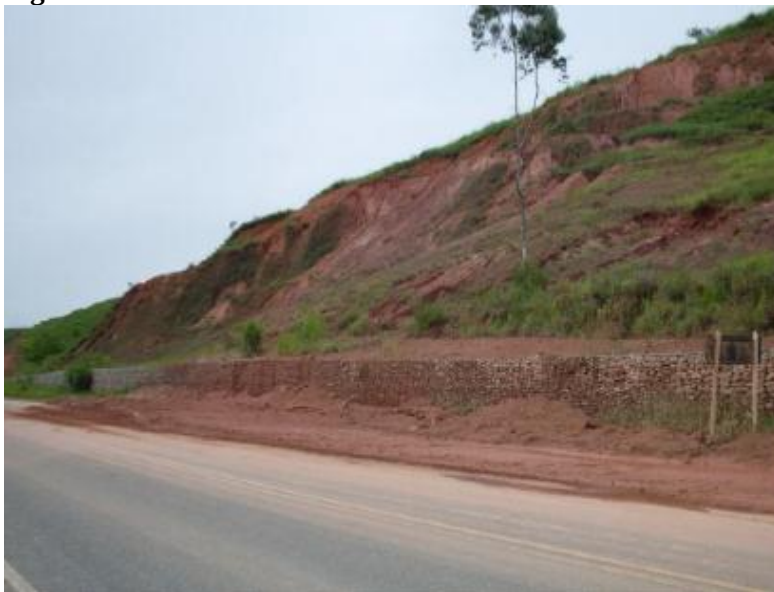
Figura 08: Talude artificial de solo.
