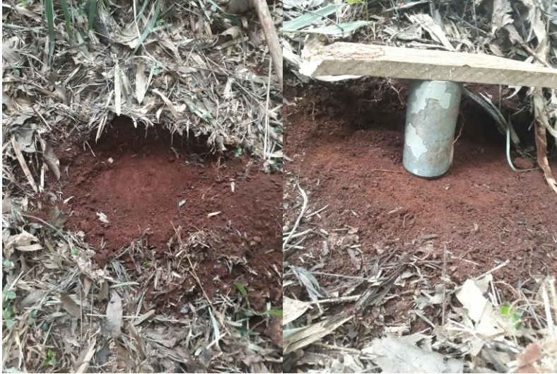
Figura 19 – Cravação do molde.
