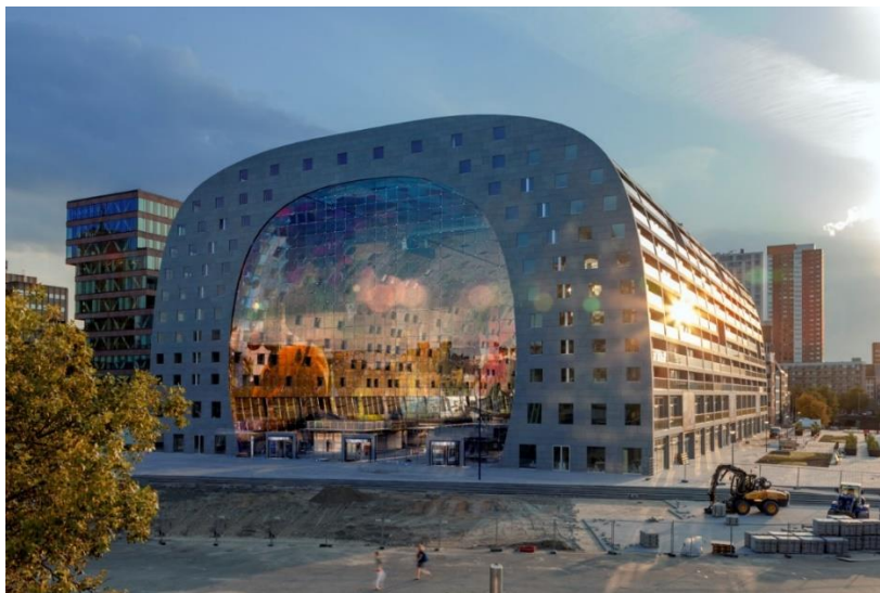
Figura 14: Fachada do mercado em vidro e formas curvas.
