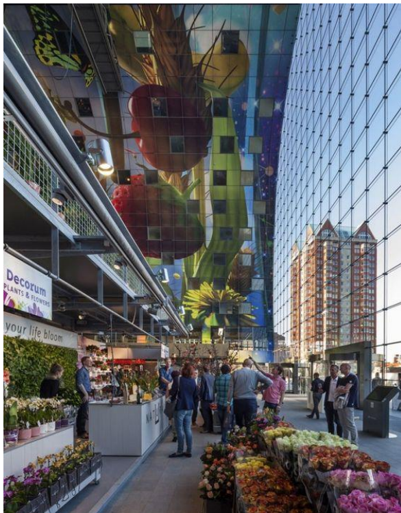
Figura 15: Grande fachada envidraçada com cabos metálicos
