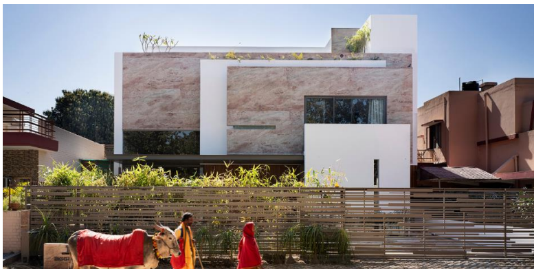
Figura 18: Fachada da residência 145
