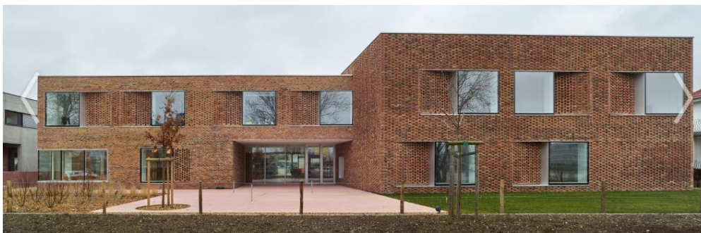
Figura 12: Fachada da moradia para idosos em Huningue.
