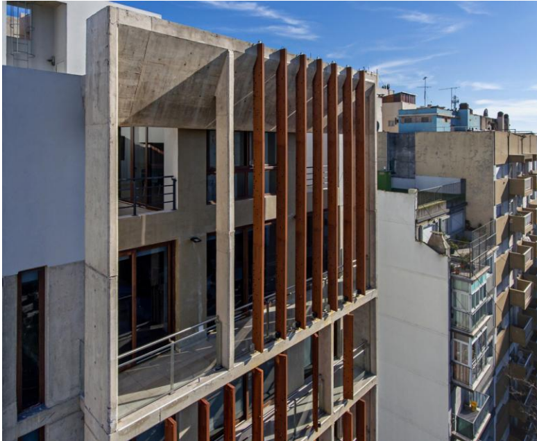
Figura 19 – Fachada concreto armado
