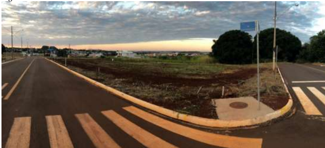
Figura 30: Vista da rua C
